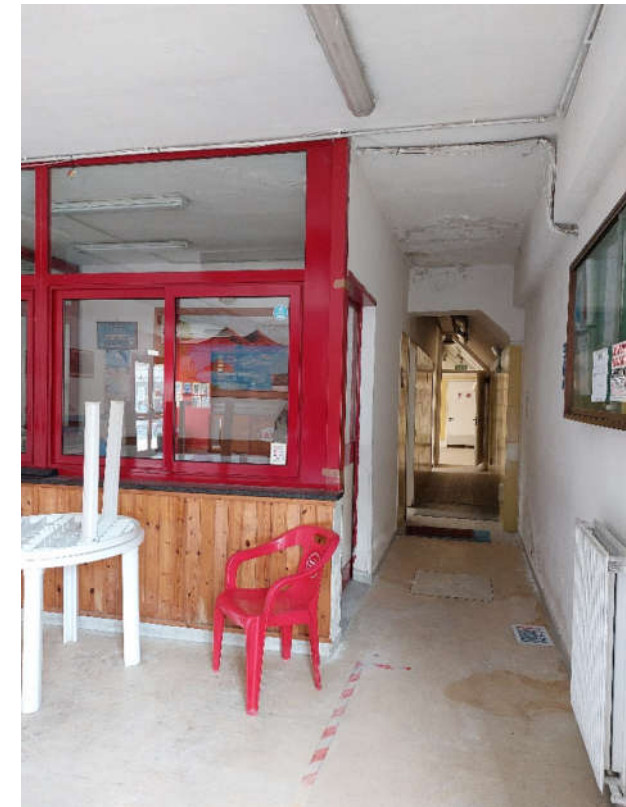
Vista interna all'impianto natatorio indoor
