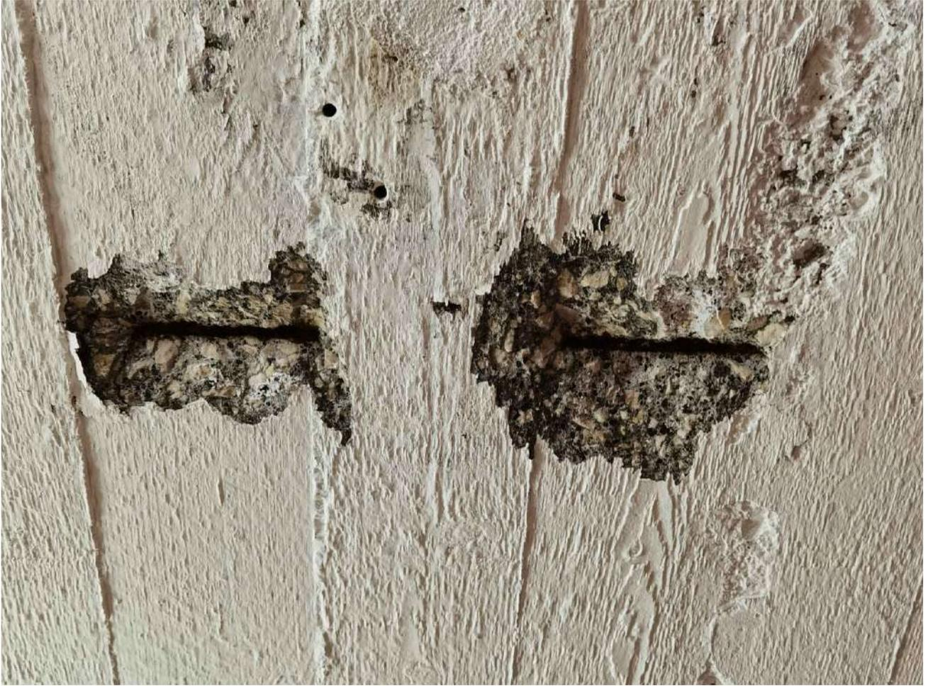
Armature ossidate (infiltrazione puntuale)
