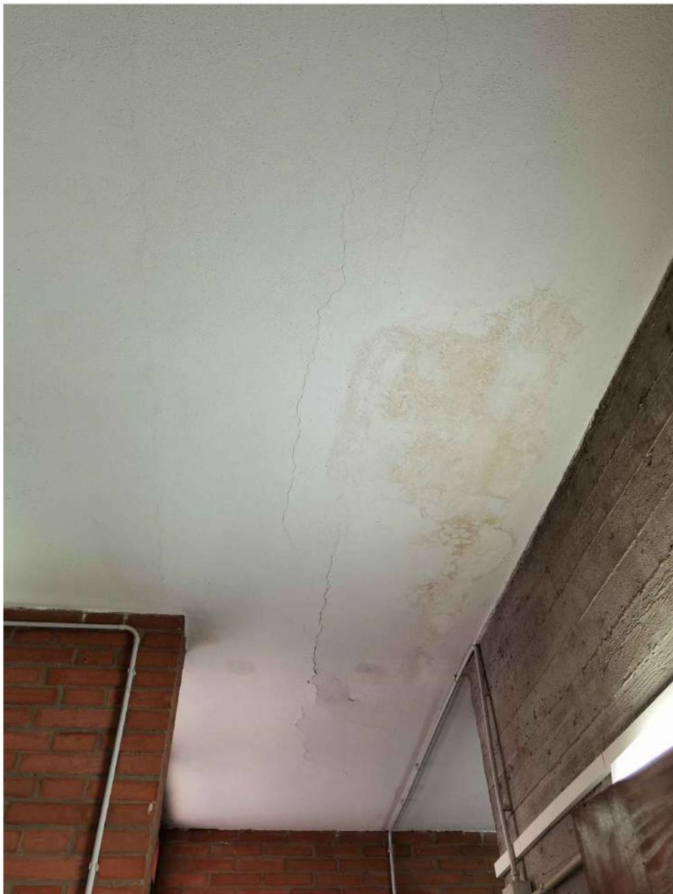
Infiltrazione in copertura e principio di sfondellamento
