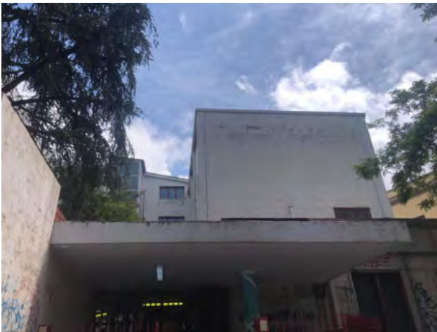
Facciata su via Puccini e pensilina
