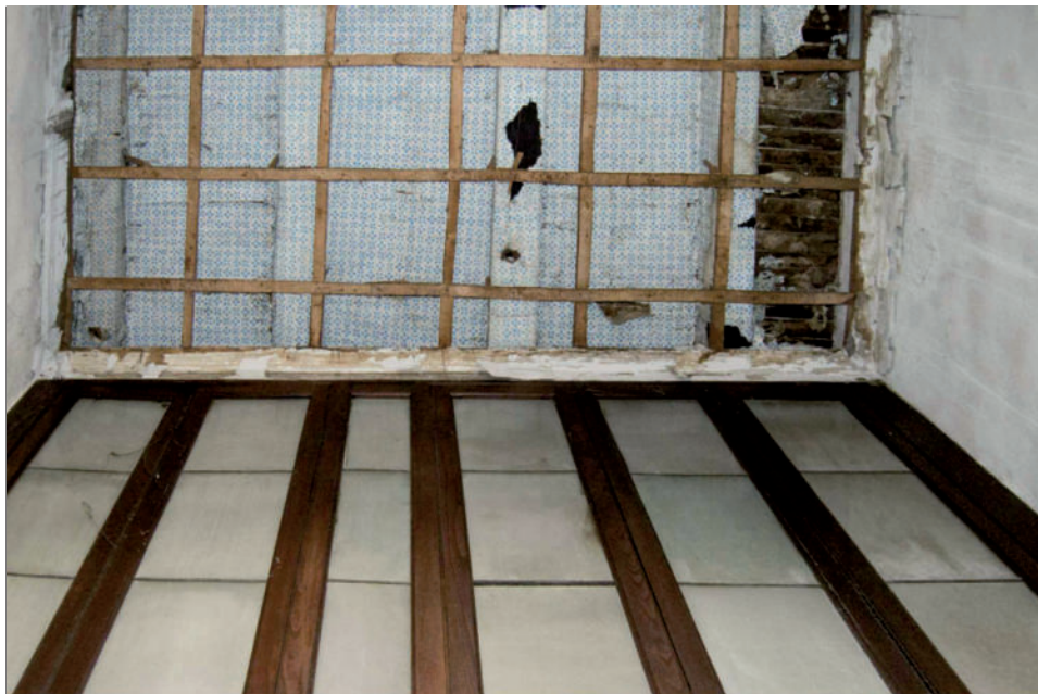
9. Ambiente con solaio ligneo con incartata
