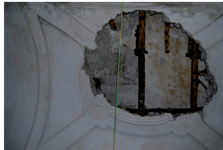
•14. Crollo della volta dell'ambiente attiguo alla Chiesa
