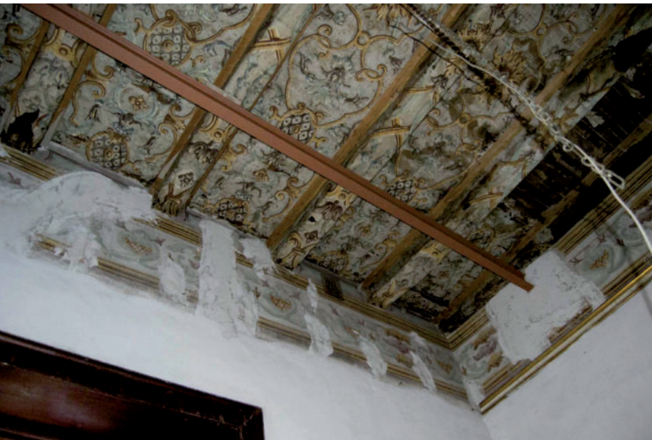
10. Ambiente con solaio ligneo con incartata
