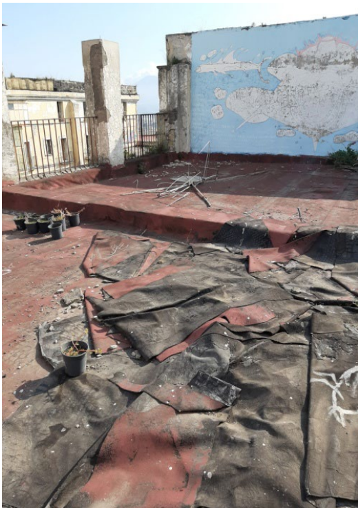
Stato terrazzo copertura quarto livello
