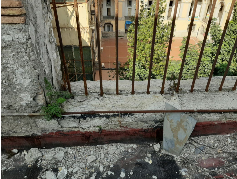
Particolare stato terrazzo copertura
