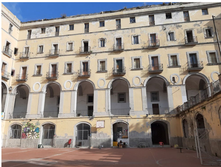
Facciate corte interna
