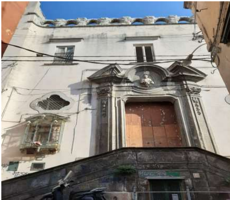
Facciata Via Pontecorvo
