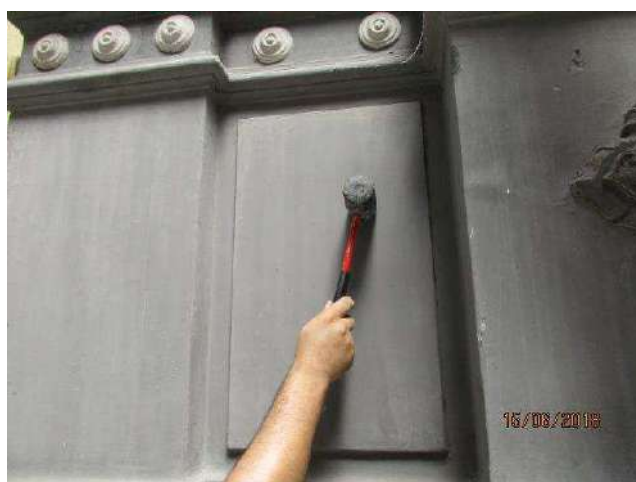
Figure 13 / 14 – Battitura con punta di plastica rigida
