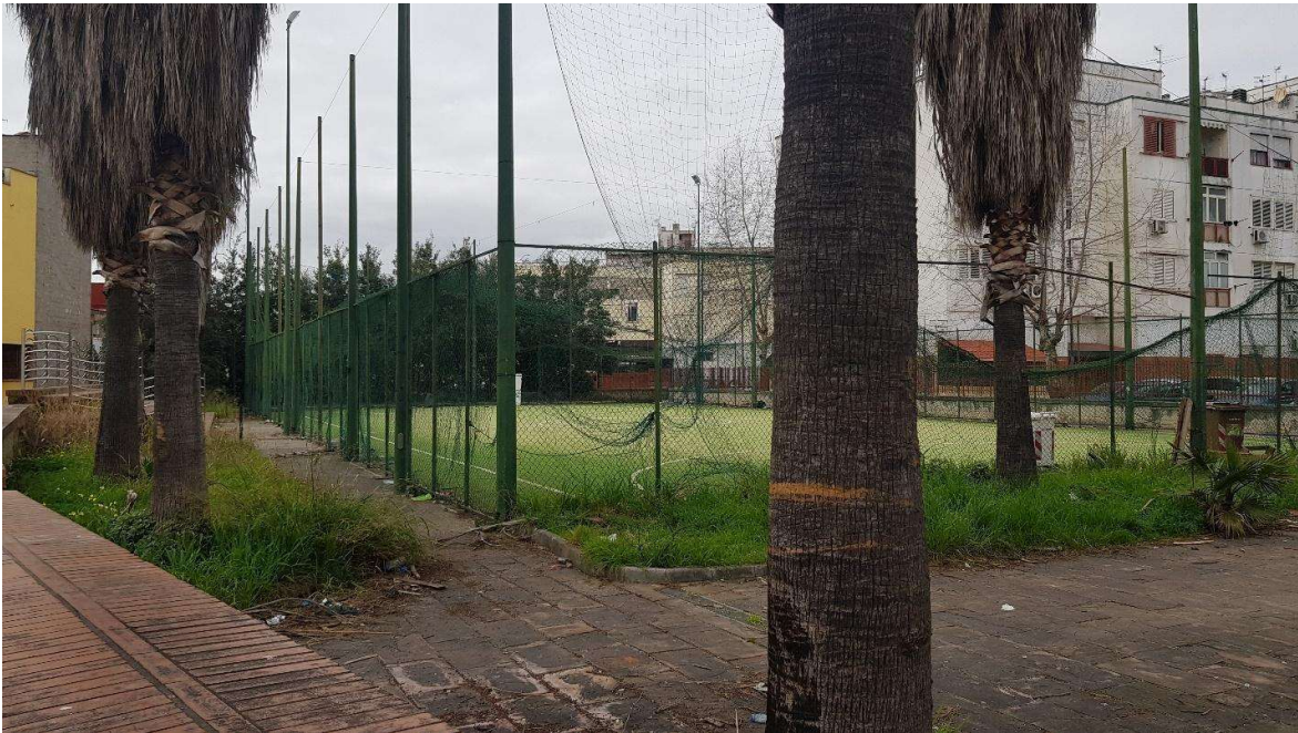
Foto n.15 Area attrezzata vandalizzata
