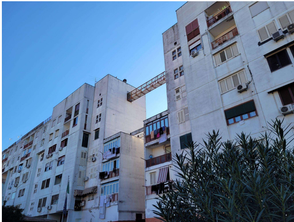
Foto n.4 - Facciata dell'edificio P4a lungo via Edoardo Scarpetta
