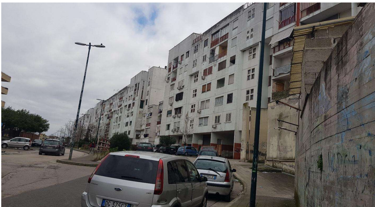
Foto n.2 - Facciata dell'edificio P4a lungo via Edoardo Scarpetta
