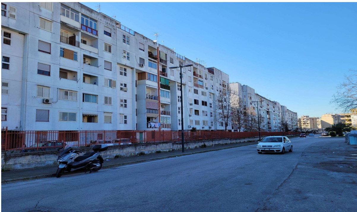
Foto n.1 - Facciata dell'edificio P4a lungo via Edoardo Scarpetta
