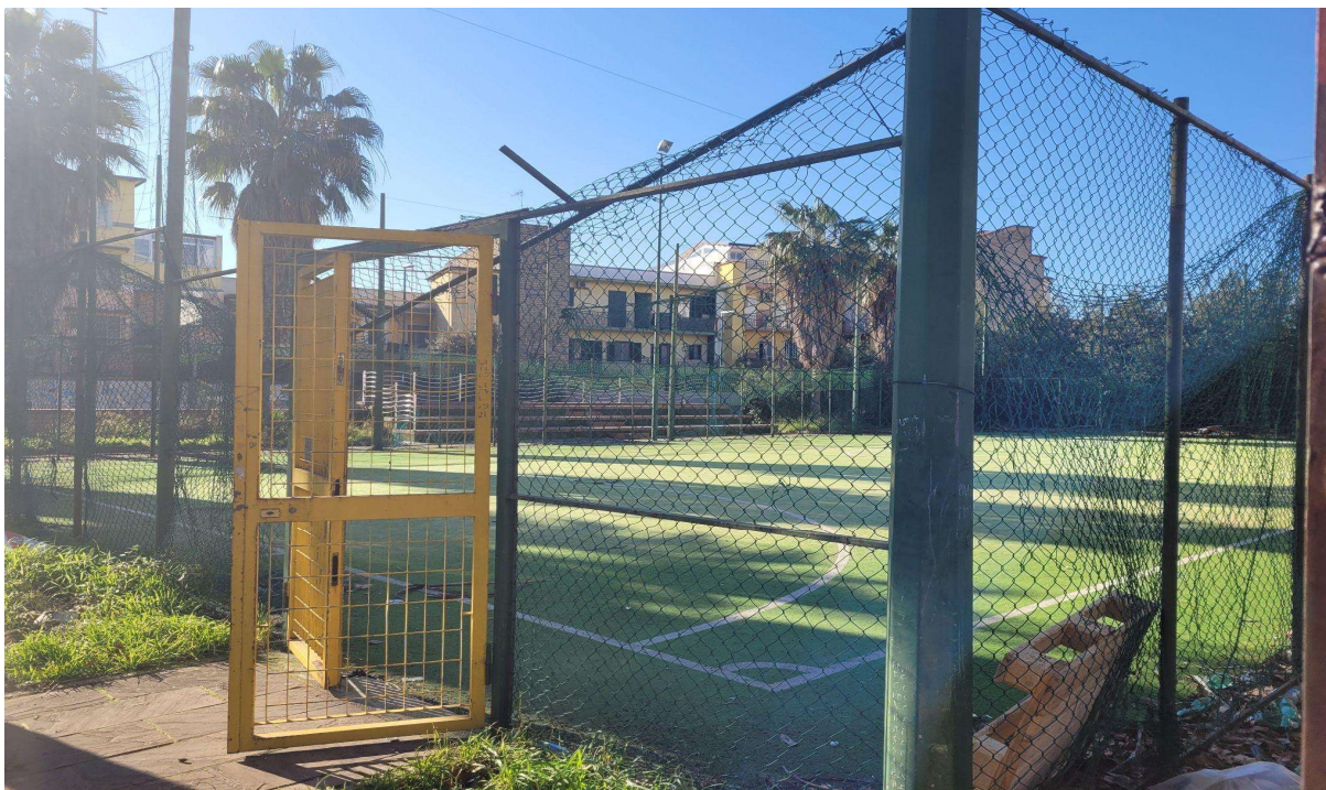
Foto n.14 Area attrezzata vandalizzata
