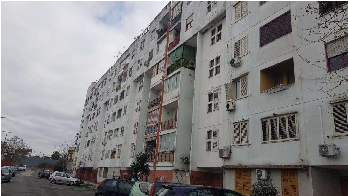
Foto n.5 - Facciata dell'edificio P4a lungo via Edoardo Scarpetta
