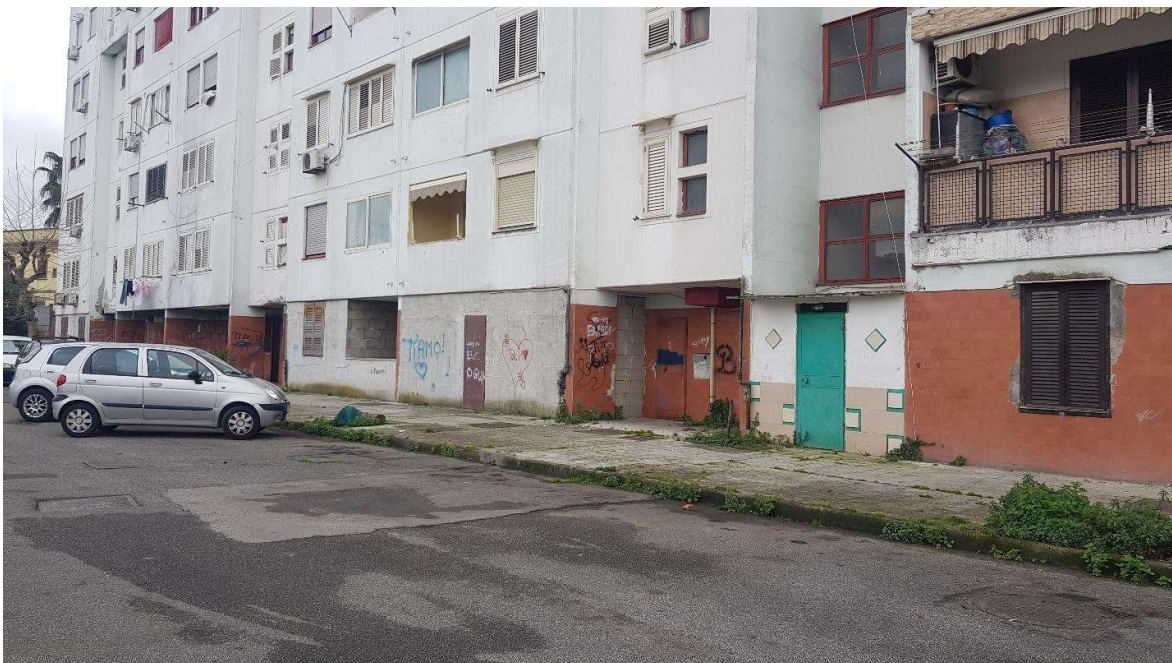
Foto n.6 - Facciata dell'edificio P4a lungo via Edoardo Scarpetta
