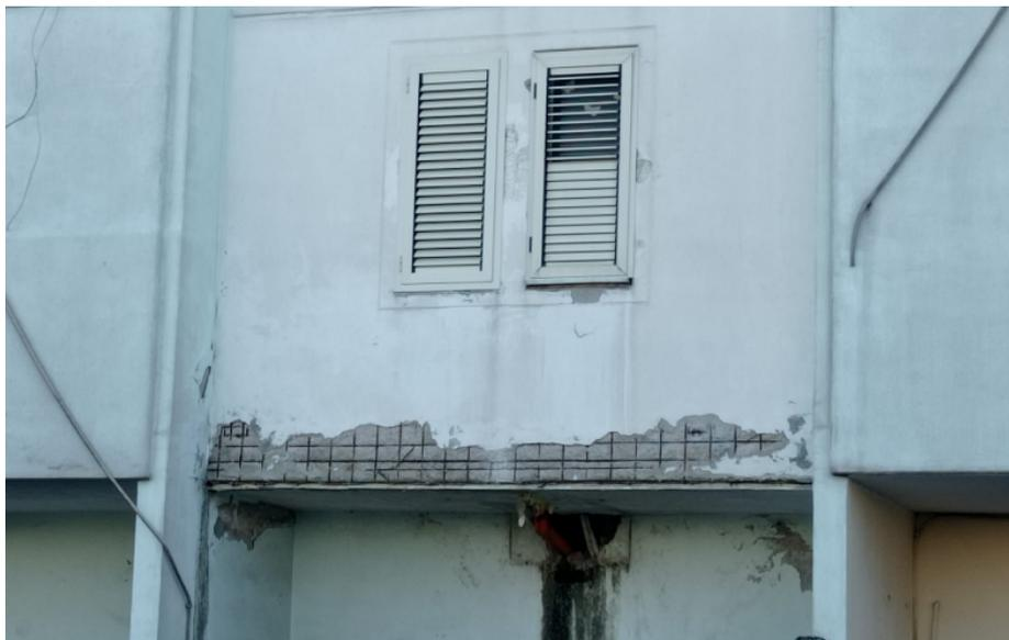
**Figura 5.17 – Corrosione delle armature delle pareti di tamponamento al piano primo**
