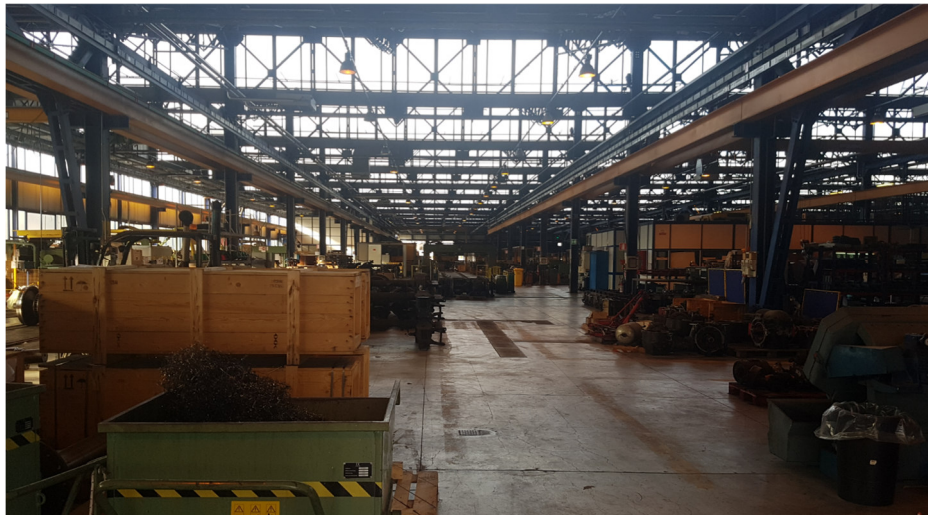
Fig. 2 – Foto dell'impianto esistente
