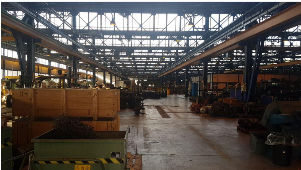
Fig. 2 – Foto dell'impianto esistente
