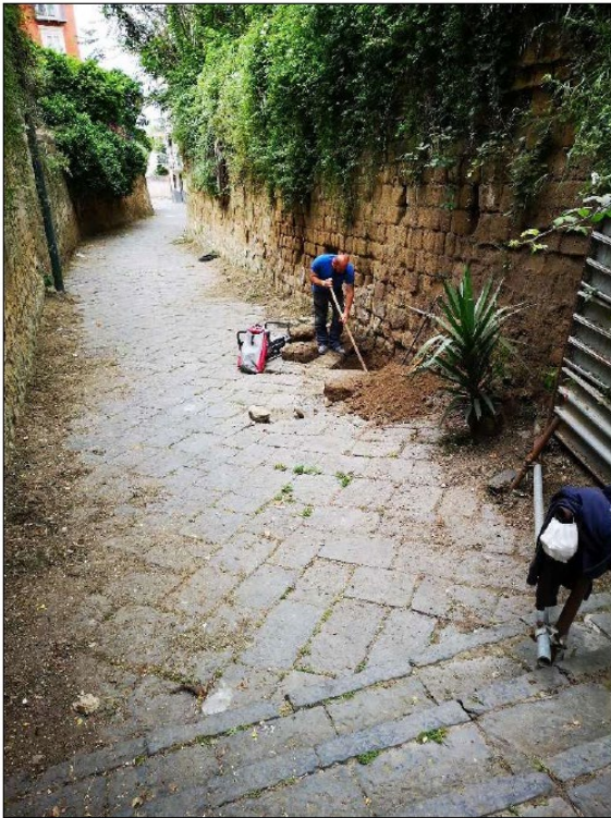
Figura 2 - scavo n° 1 realizzato in prossimità del muro crollato
