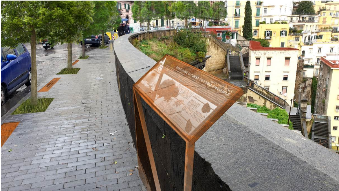
Corso Vittorio Emanuele - Inserti metallici posati in adiacenza ai cordoli, totem informativi e piantumazioni laddove possibile
