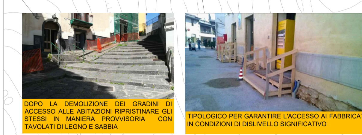
DOPO LA DEMOLIZIONE DEI GRADINI DI ACCESSO ALLE ABITAZIONI RIPRISTINARE GLI STESSI IN MANIERA PROVVISORIA CON TAVOLATI DI LEGNO E SABBIA
