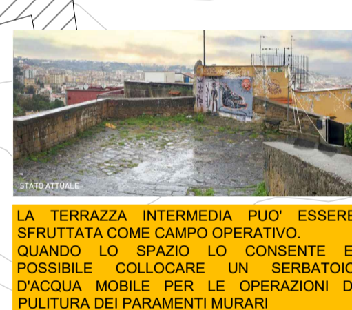
LA TERRAZZA INTERMEDIA PUO' ESSERE SFRUTTATA COME CAMPO OPERATIVO. QUANDO LO SPAZIO LO CONSENTE E' POSSIBILE COLLOCARE UN SERBATOIO D'ACQUA MOBILE PER LE OPERAZIONI DI PULITURA DEI PARAMENTI MURARI
