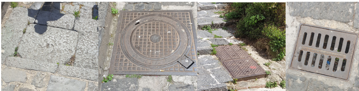
Figura 11_ Chiusino in pietra Q2 - Chiusino in metallo K1 - Chiusino in metallo K4 - Caditoia in metallo Q4
