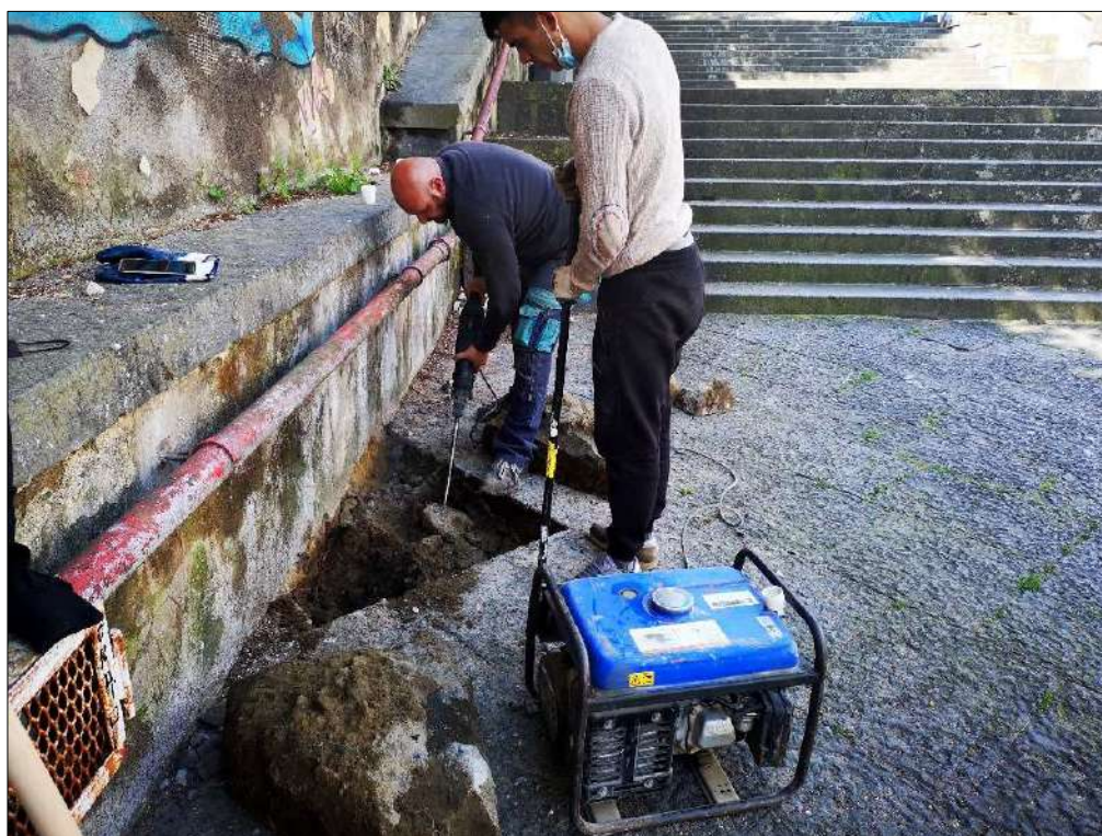
Foto 1: Scavo n° 1 realizzato nel punto in cui sarà realizzata una pensilina.
