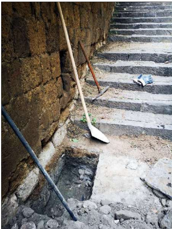
Foto 7: Scavo n° 2 in esecuzione.
