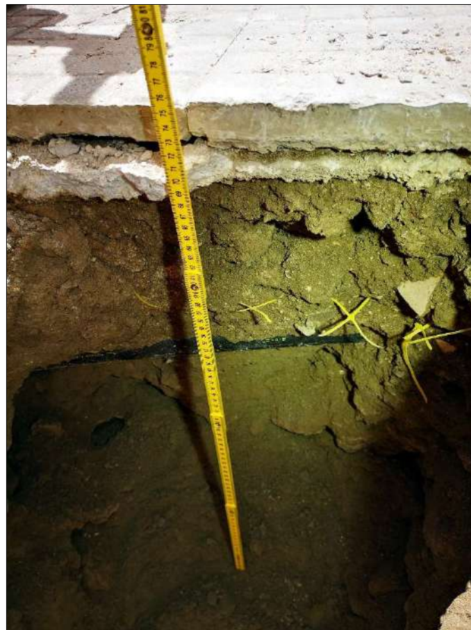
Foto 3: Particolare dello scavo; visibile tubo nero per cavo sul lato opposto rispetto alla scala del Petraio.
