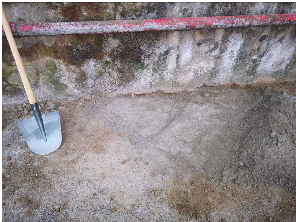
Foto 4: Ripristino dello stato dei luoghi scavo n° 1.
