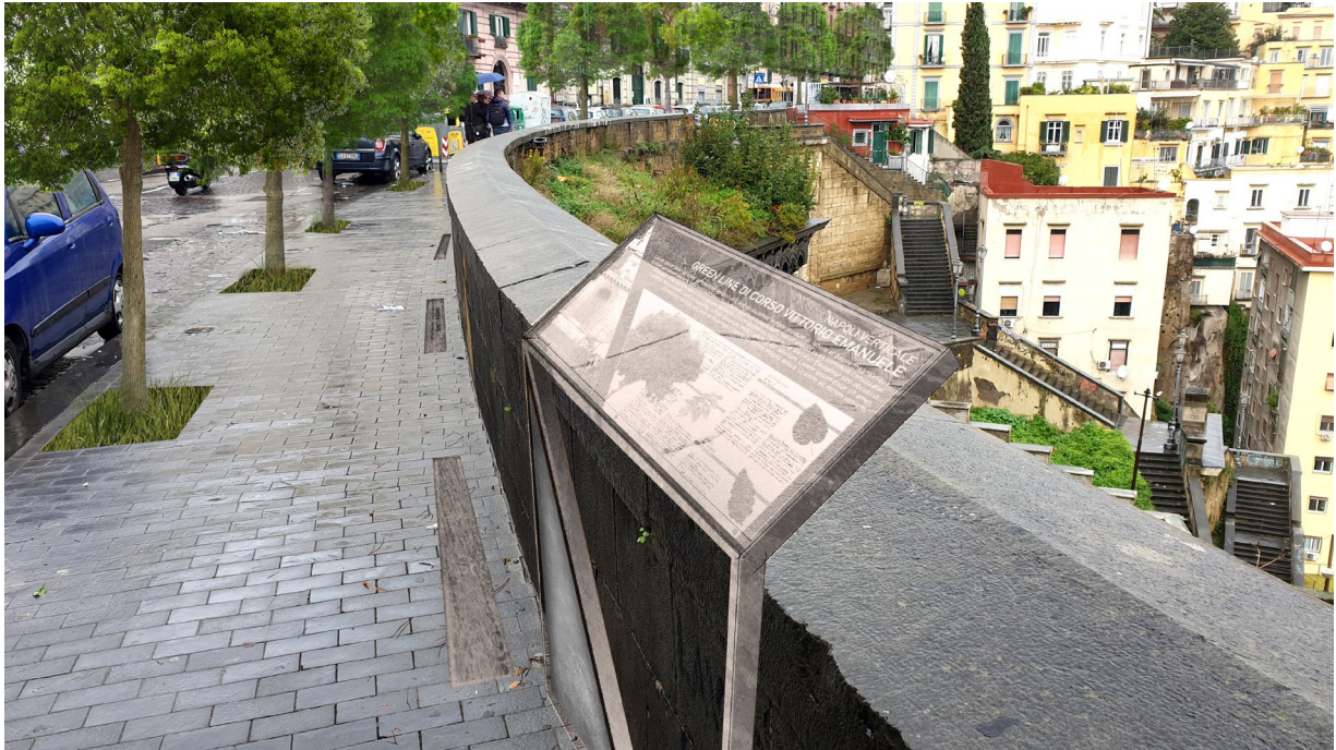
Figura 24 Corso Vittorio Emanuele - Inserti metallici posati in adiacenza ai parapetti, totem informativi e piantumazioni laddove possibile
