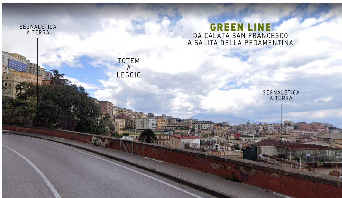
Figura 23 Corso Vittorio Emanuele - Inserti metallici posati in adiacenza ai parapetti
