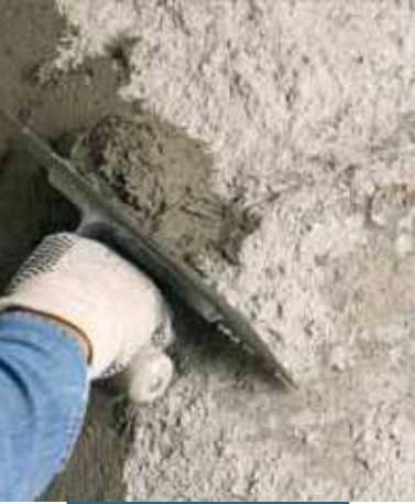
Applicazione del primo strato di Planitop HDM
