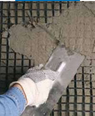
Posizionamento di Mapegrid G 220
