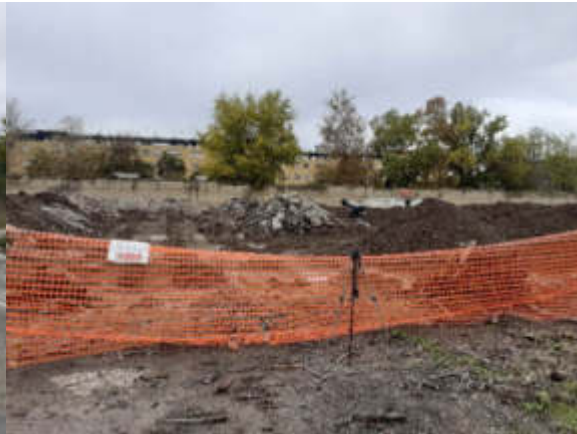
Figura 2.8: Punto di misura 03
