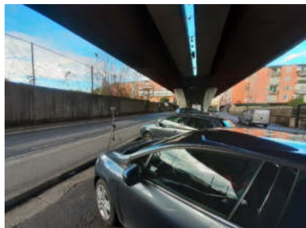
Figura 2.10: Punto di misura 05
