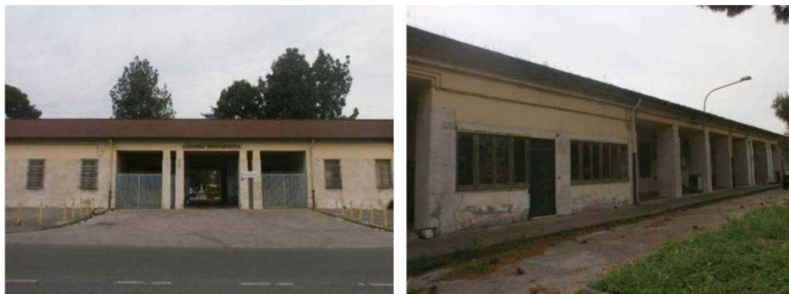
Figura 2.22: Vista sull'Edificio di Ingresso alla Caserma
