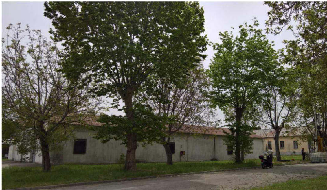
Figura 2.33: Ambito di Vegetazione ad Alto Fusto "A" (ad Ovest) – Ripresa Fotografica
