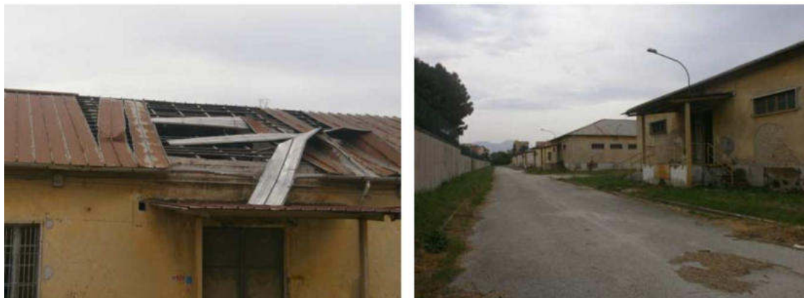
Figura 2.21: Stato di Conservazione della Caserma
