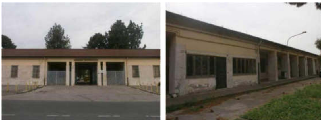
Figura 4.32: Vista sull'Edificio di Ingresso alla Caserma
