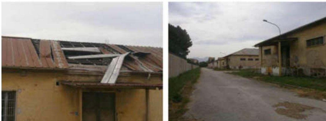
Figura 4.31: Stato di Conservazione della Caserma
