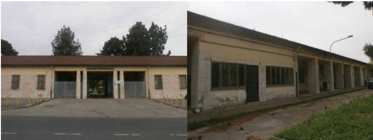
Viste sull'edificio di ingresso al compendio (Edificio T)
