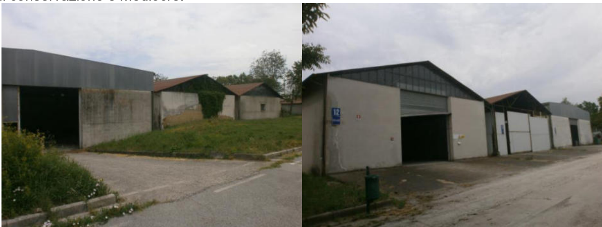
Viste sui capannoni esistenti (H, I, L, M, N)
