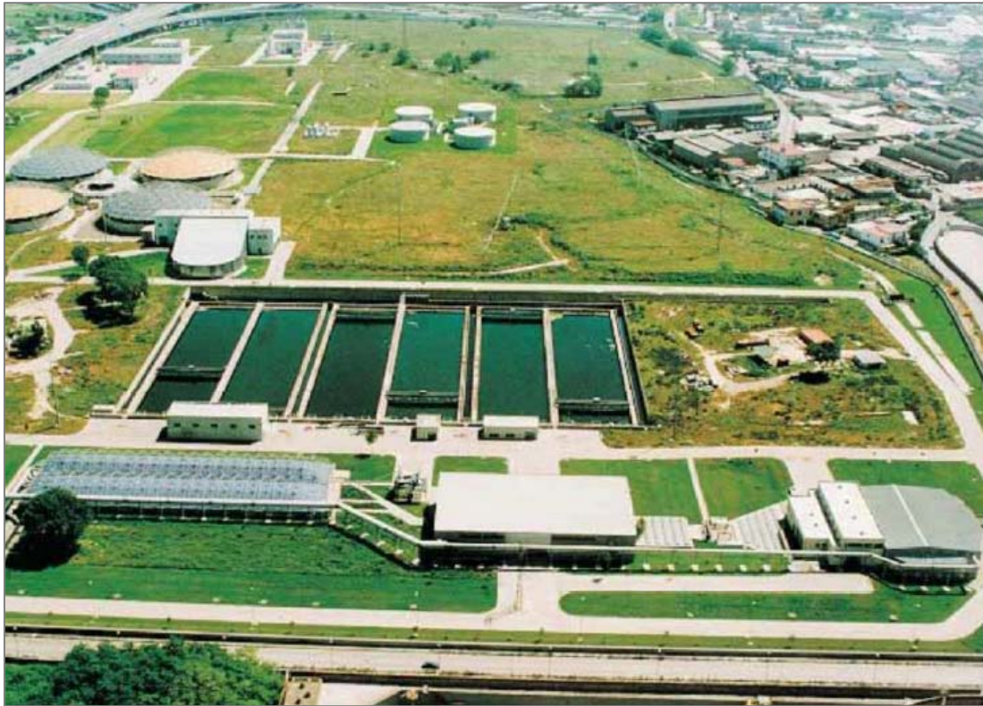
Fig.27.: Vista aerea del Depuratore "Napoli Est" con, in alto sullo sfondo, l'area di progetto
