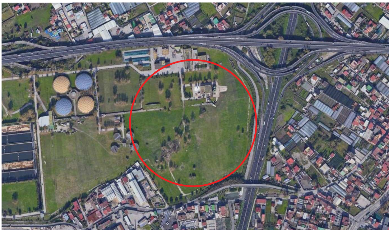
Immagine google earth 2020 con identificazione del sito
