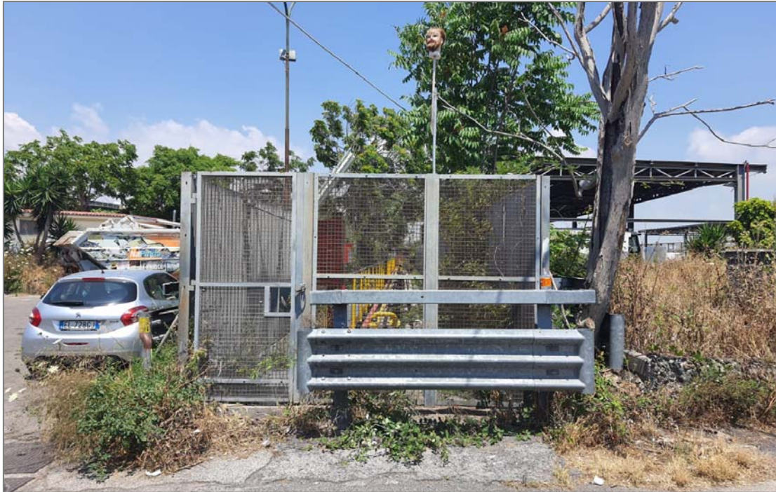
Fig.20 FOTO 01 – Cancello di accesso all'area delimitata dell'oleodotto e del relativo impianto antincendio
