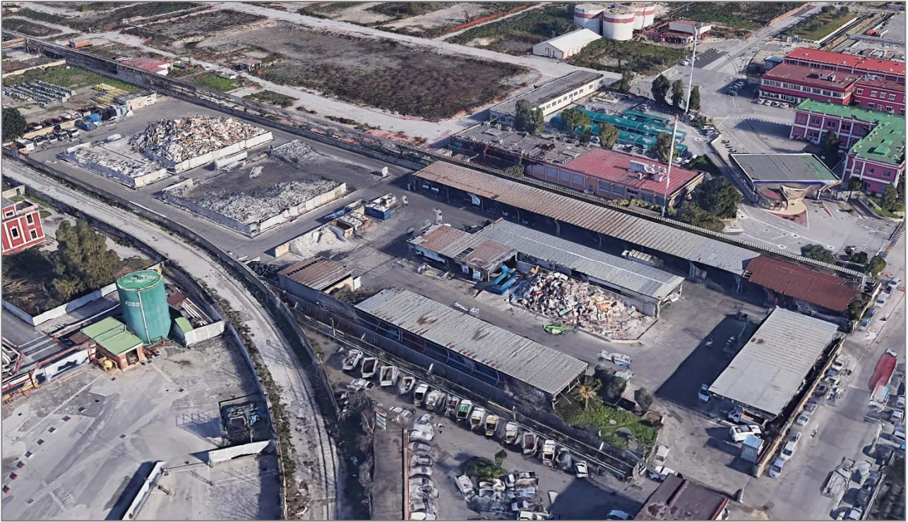
Fig.16 Vista aerea di dettaglio dell'Area Centro di Raccolta (sulla destra) e sul retro, più a sinistra le piazzole scoperte di stoccaggio rifiuti pavimentate
