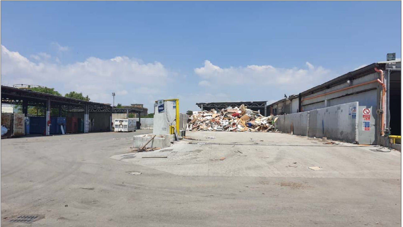
Fig.26 FOTO 07 – Aree di stoccaggio pavimentate ma scoperte nell'area B
