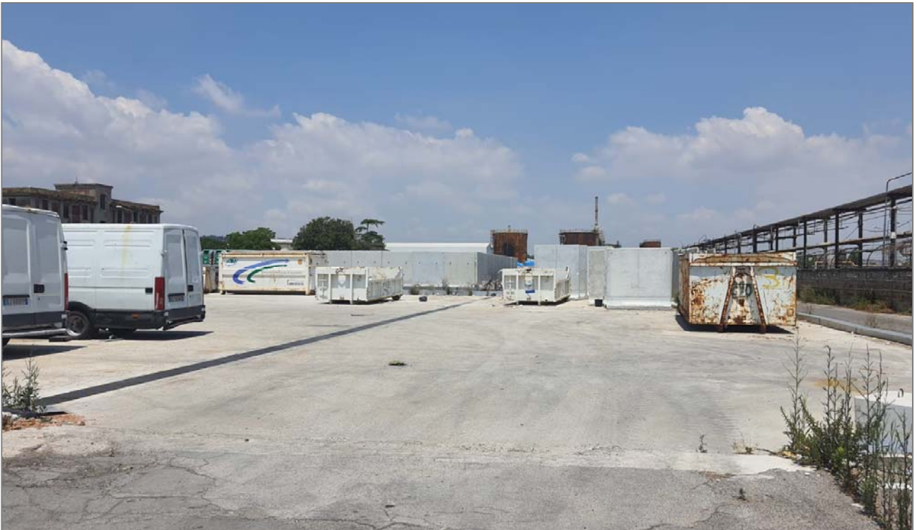
Fig.31 FOTO 12 – Aree di stoccaggio pavimentate ma scoperte nell'area C
