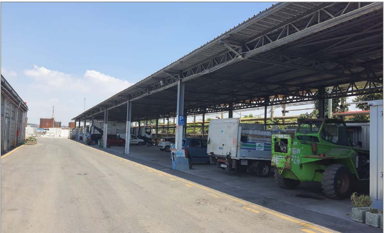
Fig.25 FOTO 06 – Vista delle tettoie di copertura delle aree di stoccaggio e parcheggio posizionate nell'Area B
