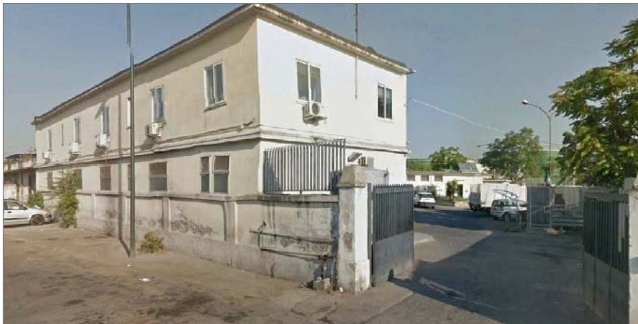
Fig.14 Dettaglio dell'ingresso all'area uffici e della Palazzina uffici esistente
