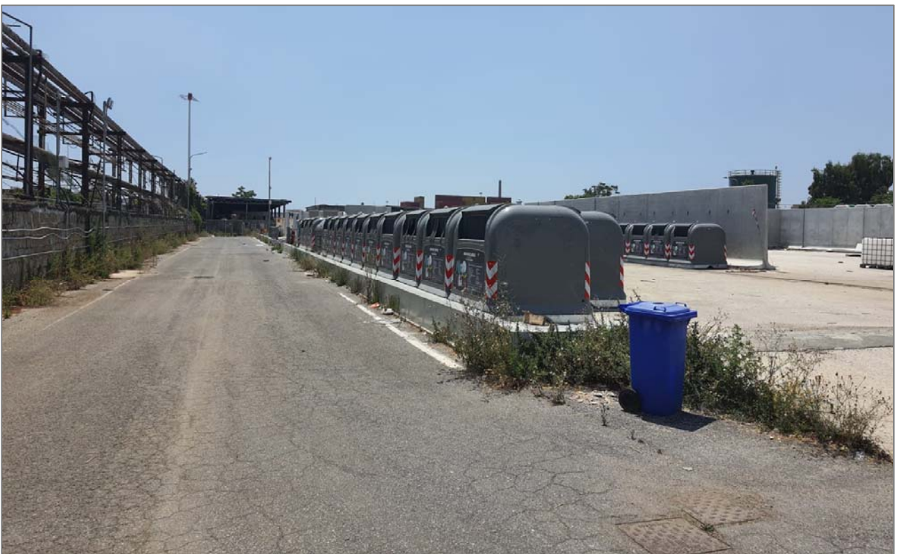
Fig.29 FOTO 10 – Aree di stoccaggio pavimentate nell'area C e (a sinistra) struttura metallica di sostegno di tubazioni aeree posta a fianco del confine Est dell'area
