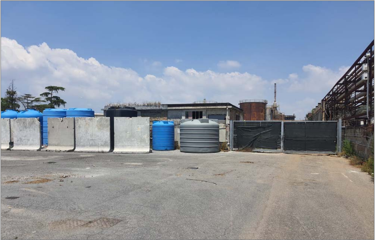
Fig.30 FOTO 11 – Cancelli di accesso all'area D e cisterne stoccate nell'area C
