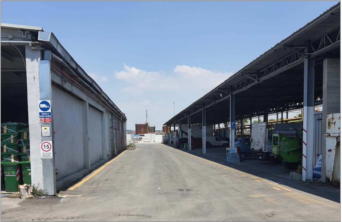
Fig.24 FOTO 05 – Vista delle tettoie di copertura delle aree di stoccaggio e parcheggio posizionate nell'Area B
