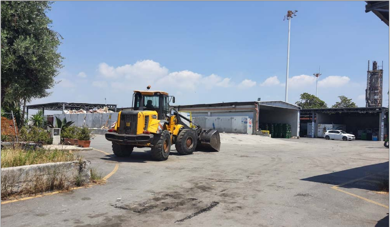
Fig.22 FOTO 03 – Vista generale dell'area in cui indicativamente si rileva il passaggio del collettore FUGIST (di pertinenza del Depuratore di Napoli Est)
