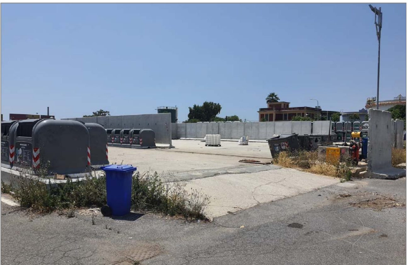
Fig.27 FOTO 08 – Aree di stoccaggio pavimentate ma scoperte nell'area C
