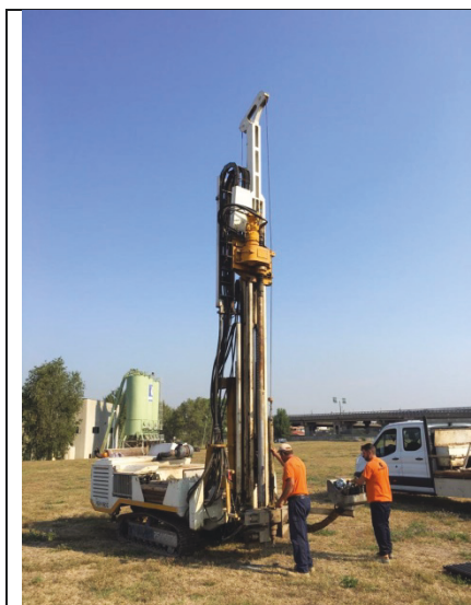
Figura 6 Operazioni di perforazione
