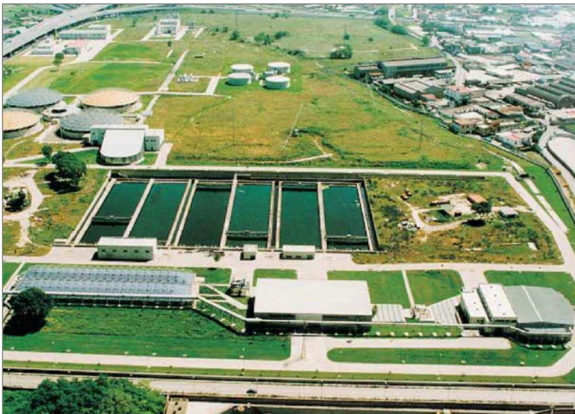
Fig.46.: Vista aerea del Depuratore "Napoli Est" con, in alto sullo sfondo, l'area di progetto
