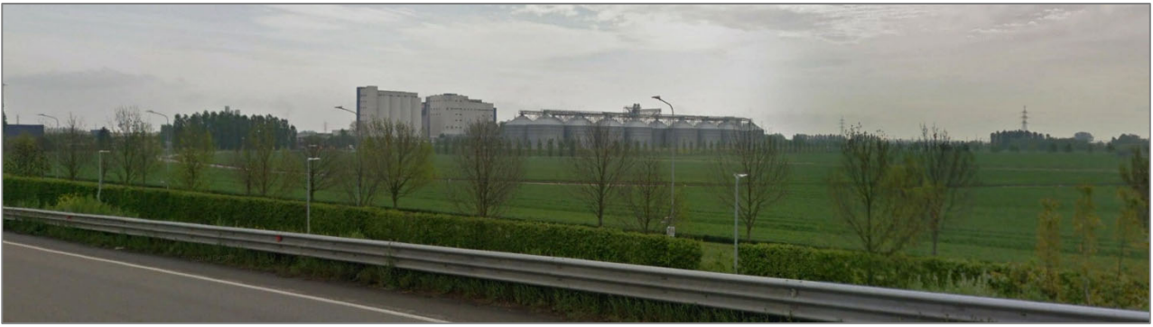
Fig.123.: Esempio di intervento di mitigazione con rilevati in terra e filari di alberi a contorno (Depositi stabilimento Barilla- Parma) – Vista panoramica
