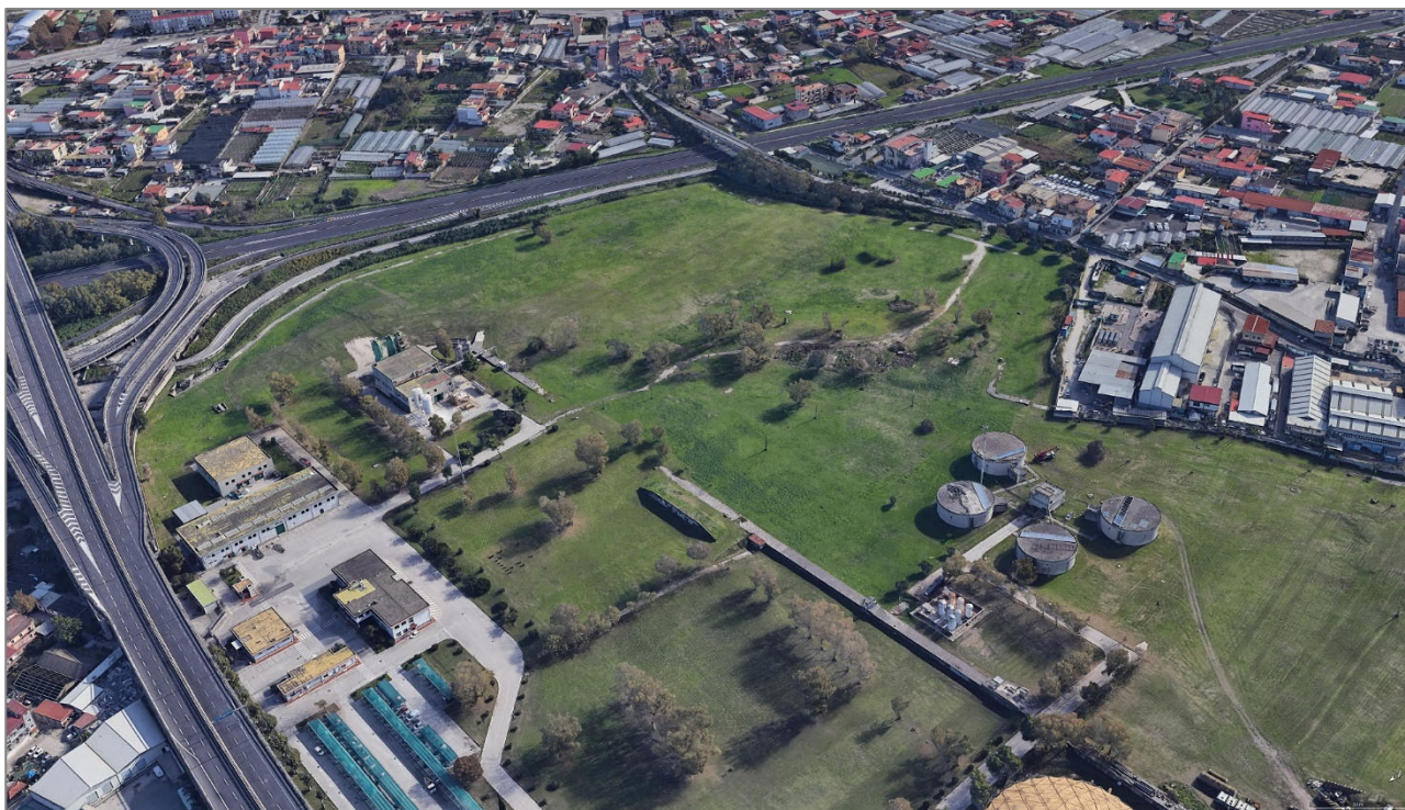
Fig.117.: Vista Aerea n.3 – Lato Nord-Ovest - STATO DI FATTO
