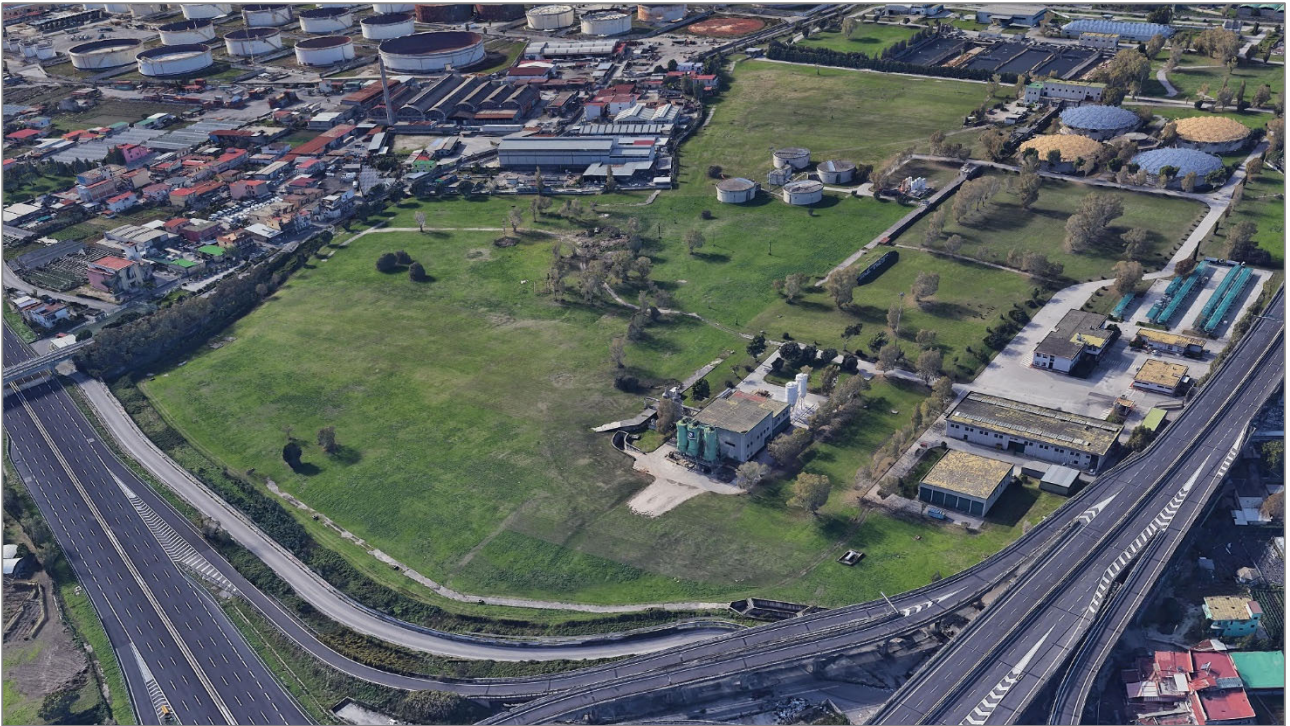
Fig.113.: Vista Aerea n.1 – Lato Nord-Est - STATO DI FATTO
