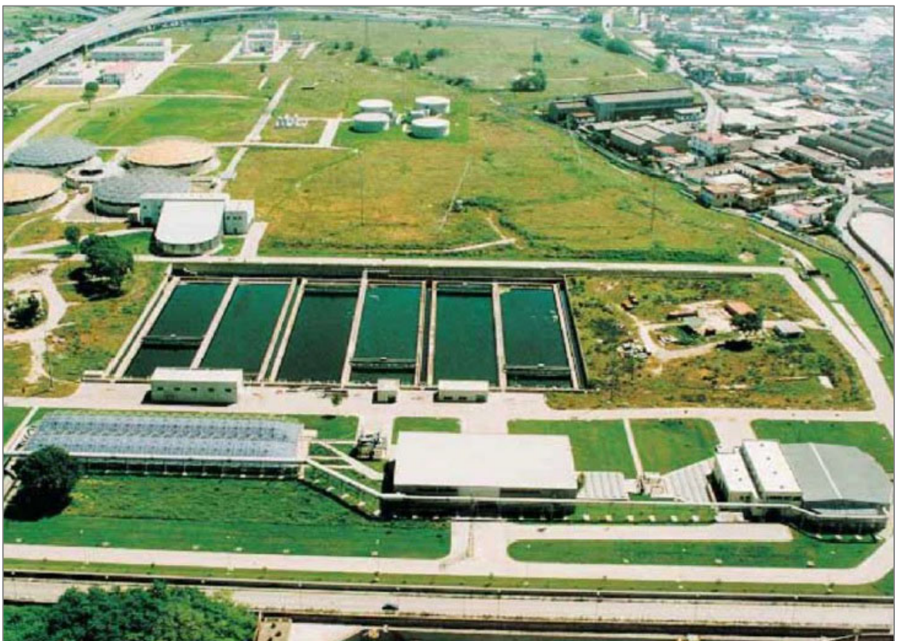
Fig.42.: Vista aerea del Depuratore "Napoli Est" con, in alto sullo sfondo, l'area di progetto
