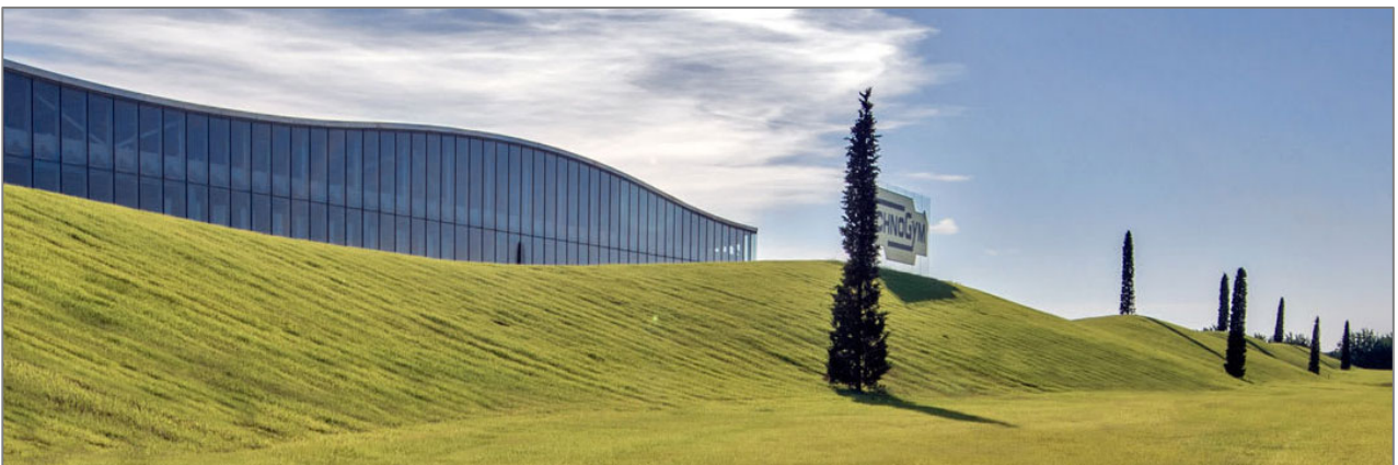
Fig.125.: Esempio di intervento di mitigazione con rilevati in terra ad altezza variabile (Technogym Village – Cesena) – Vista panoramica e dettaglio dei rilevati
