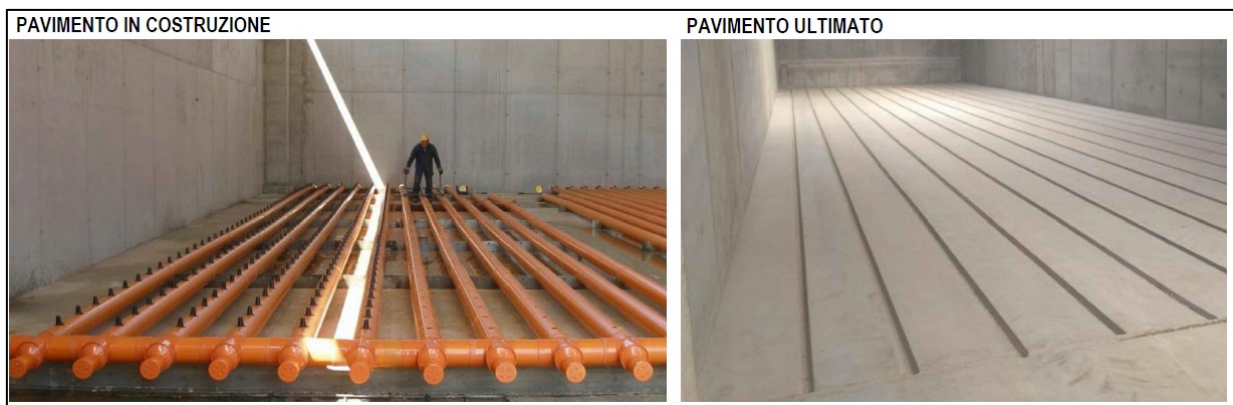
Fig.66.: Immagini della pavimentazione aerata con sistema "spigot"
