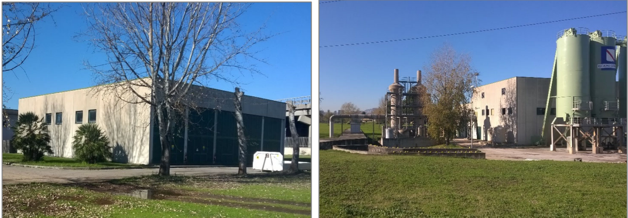
Fig.43.: Immagini di fabbricati ed impianti del Depuratore a confine con il lotto
