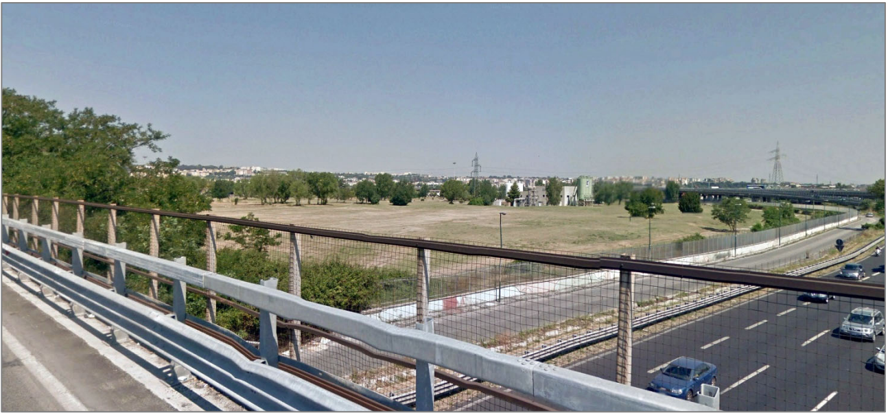
Fig.109.: Vista n.3 (lato Sud-Est – Cavalcavia Via Provinciale delle Brecce) – STATO DI FATTO
