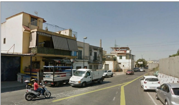
Fig.49.: Vista dei fabbricati attestati su Strada Provinciale delle Brecce (sulla sinistra la recinzione del lotto)
