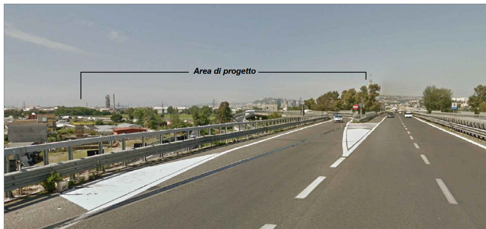
PUNTO DI VISTA "F" - (vista sopraelevata da SS162dir - lato Nord/Est) Visualità chiusa dal complesso intreccio infrastrutturale di rampe dello svincolo e dalla vegetazione posta in prossimità dello svincolo; l'area di progetto è solo parzialmente visibile in lontananza
