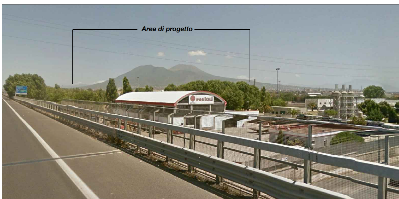
PUNTO DI VISTA "A" - (vista sopraelevata da SS162dir - lato Nord/Ovest) Visualità chiusa da fabbricati industriali in primo piano e dalla vegetazione dell'area del Depuratore Napoli-Est in secondo piano. Sullo sfondo il profilo del Vesuvio che non verrà in alcun modo schermato dai profili dei nuovi fabbricati.
