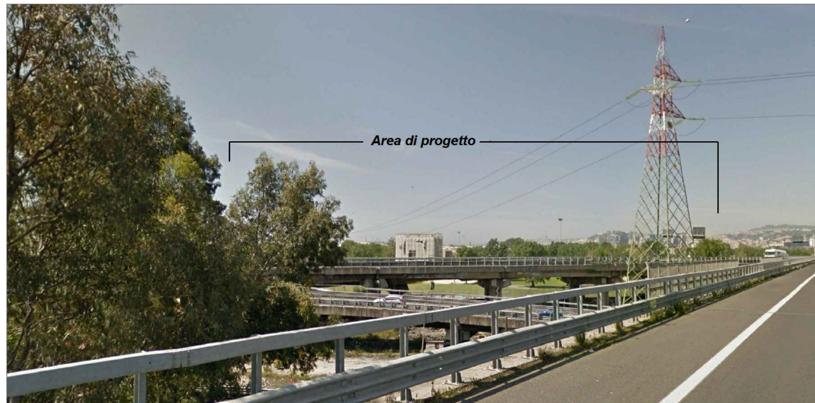
PUNTO DI VISTA "D" - (vista sopraelevata da SS162dir - lato Nord/Est) Visualità chiusa dal complesso intreccio infrastrutturale di rampe di accelerazione e decelerazione dello svincolo autostradale. L'area di progetto è in secondo piano oltre il viadotto.
