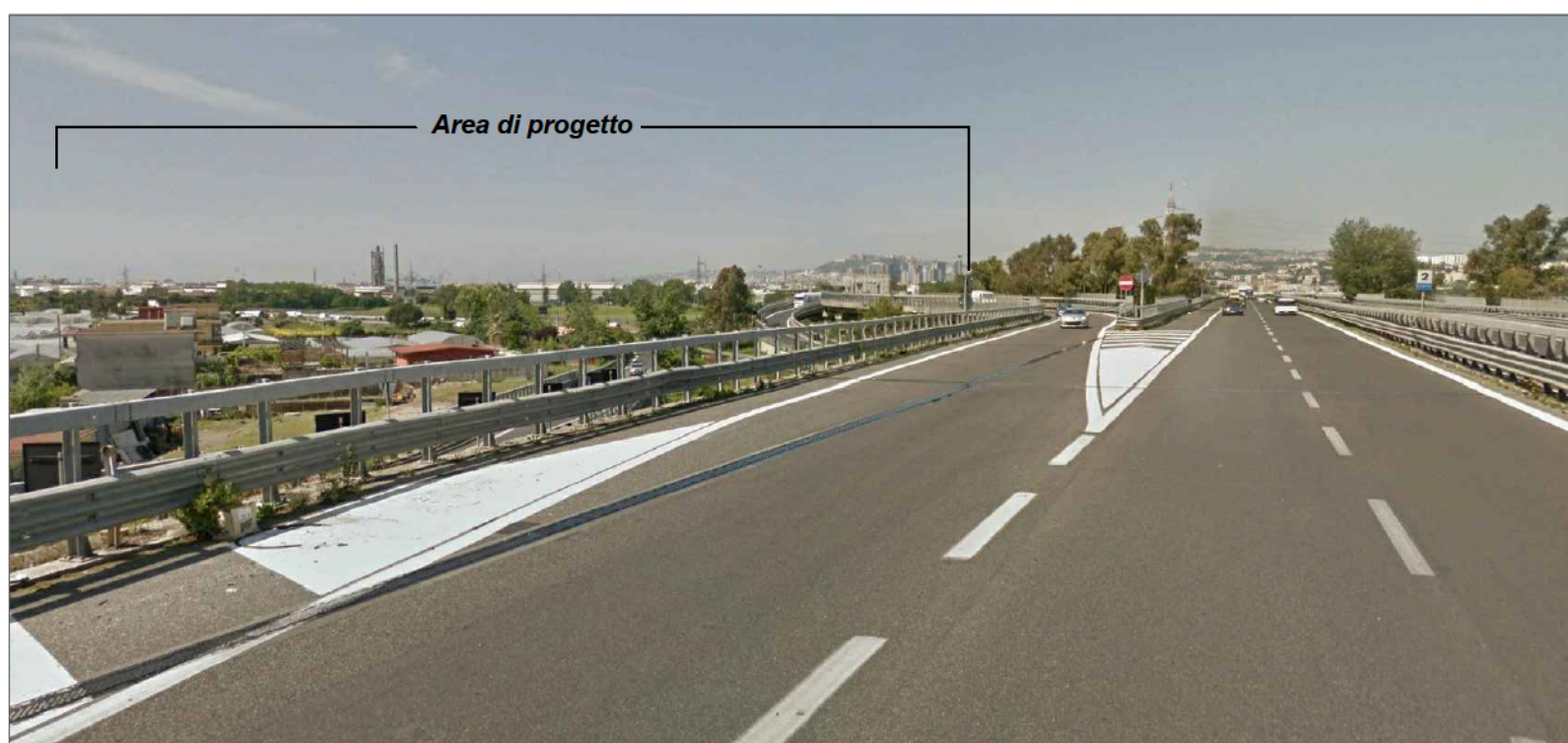
PUNTO DI VISTA "N" - (vista da Via D. De Roberto - lato Nord/Ovest) Visualità chiusa da fabbricati di tipo industriale in primo piano, dal viadotto della SS162dir in secondo piano e dalla vegetazione del Depuratore Nord-Est sul retro.
