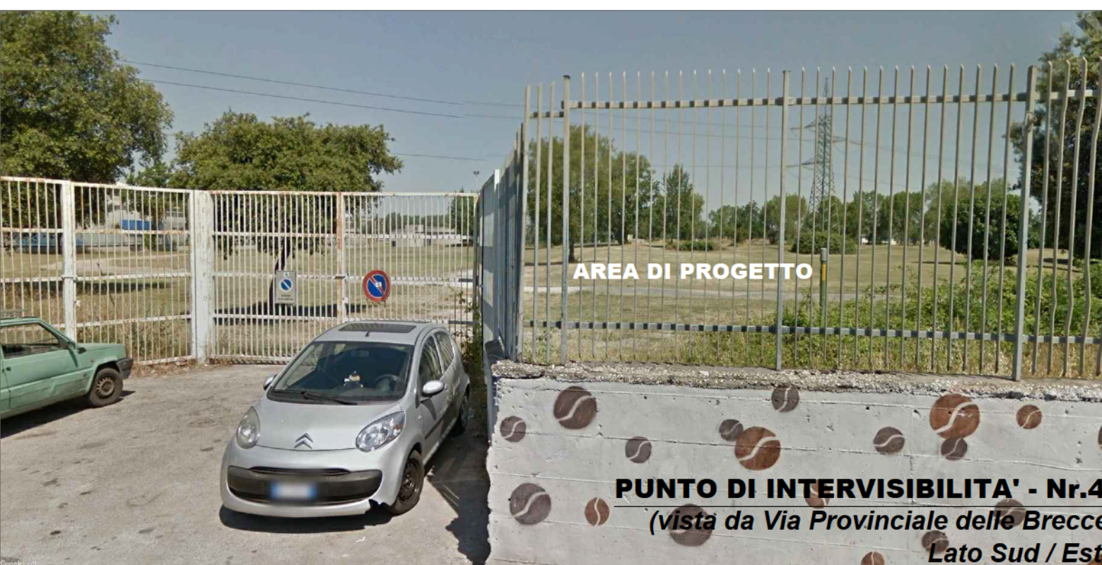
Sul lato Sud si trova Via Provinciale delle Breccie, separata dal lotto da un semplice muro in c.a. a sostenere una recinzione metallica che permette comunque di osservare da vicino l'interno del futuro impianto ( VISUALITA' APERTA ). Dalla parte opposta della strada si trovano alcuni fabbricati residenziali e piccole attività commerciali; anche in questo caso si tratta quindi di ulteriore punto fondamentale per la valutazione dell'impatto paesaggistico, anche se molto ravvicinato al limite dell'area.
