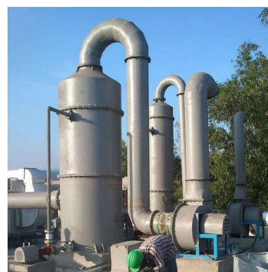
Fig.37.: Vista tridimensionale di tipologico di biofiltro simile a quello in progetto e dettaglio di "SCRUBBER"
