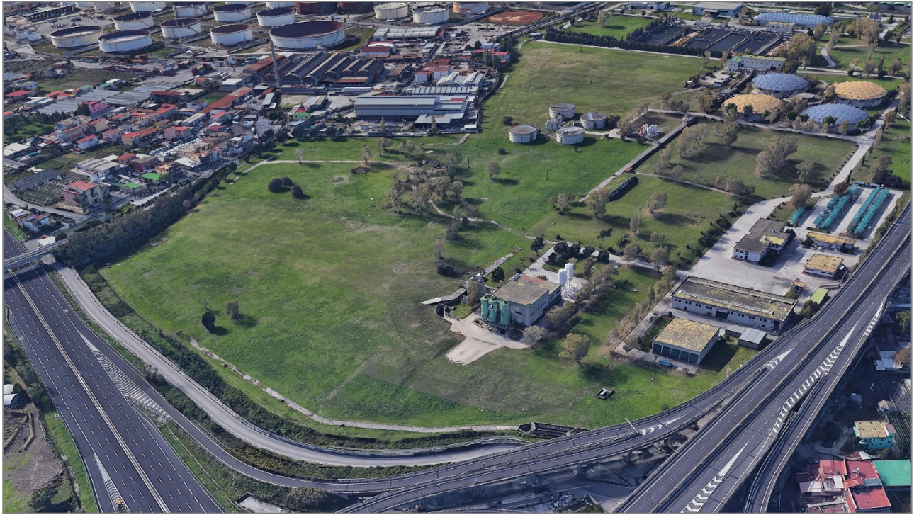
Fig.56.: Vista Aerea n.1 – Lato Nord-Est - STATO DI FATTO
