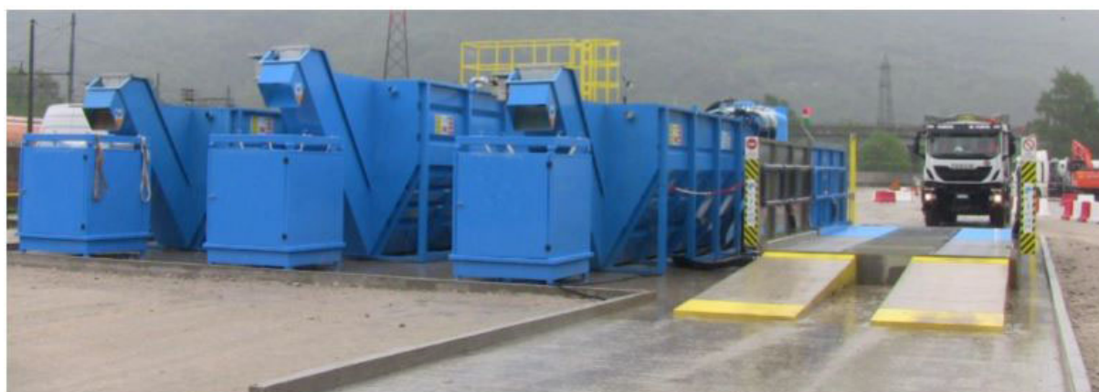
Fig.46.: Tipologico lavaggio ruote e impianto di trattamento delle acque
