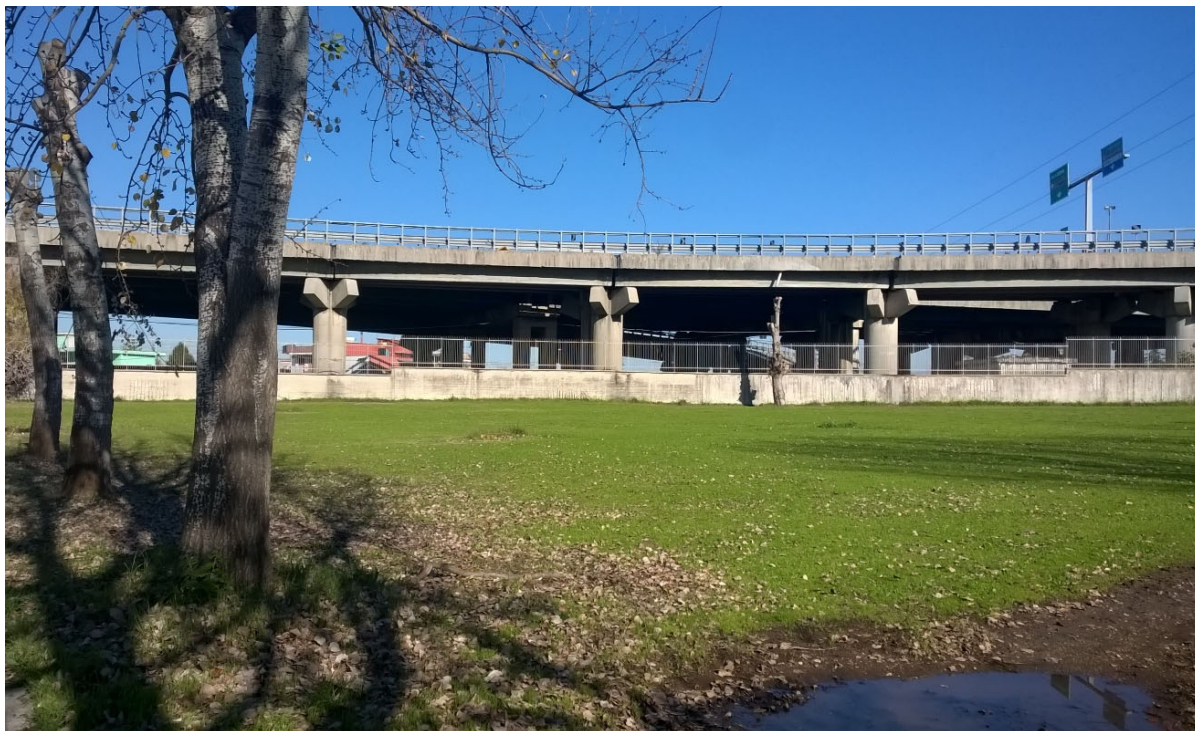
Fig. 9.: Vista di dettaglio dell'asse stradale a due livelli posto sul lato Nord
