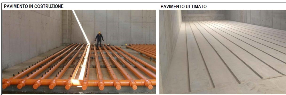
Fig.26.: Immagini della pavimentazione aerata con sistema "spigot"
