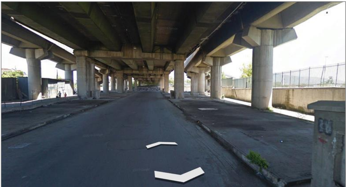
Figura 5 – Immagine di Via De Roberto, al di sotto del Viadotto della SS 162 Dir (l'area di progetto è oltre la recinzione sulla destra)
