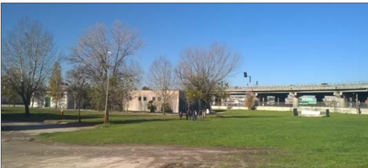
IMMAGINE 14 - Vista della sopraelevata della SS162dir, dei capannoni del Depuratore di Napoli Est e della vegetazione
