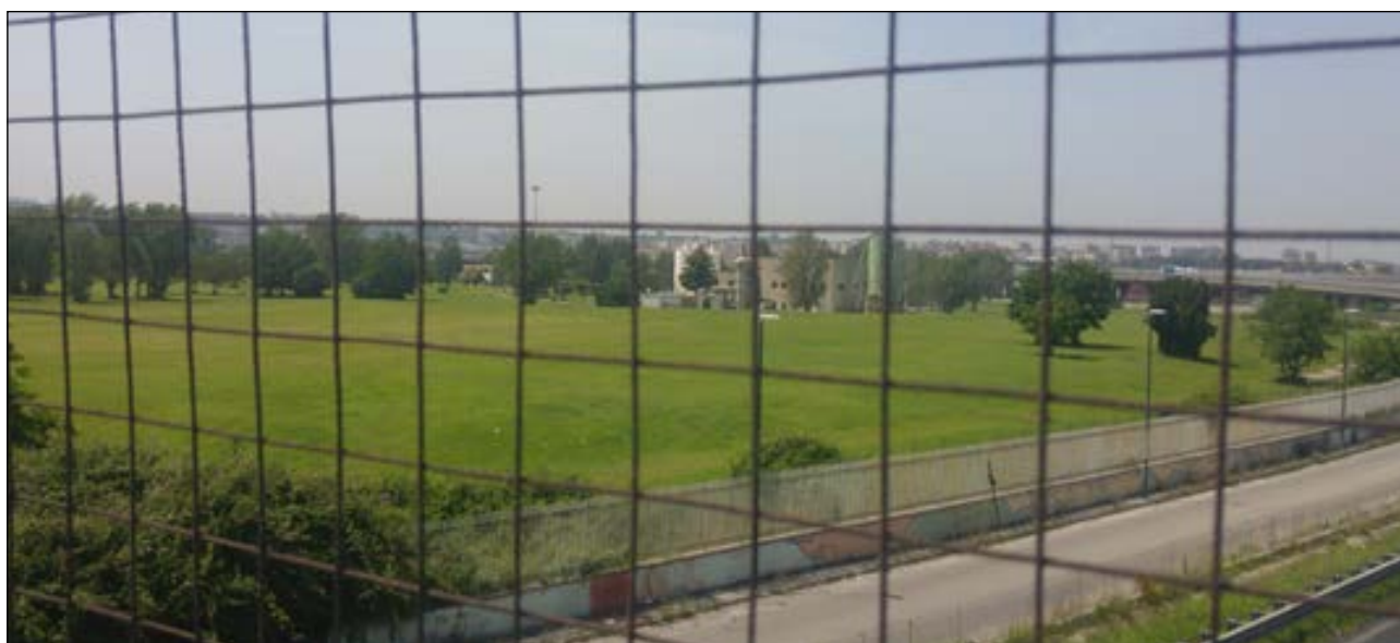
IMMAGINE 21 - Vista generale dell'area di intervento da Via Provinciale delle Breccie (dal sovrappasso dell'Autostrada)
