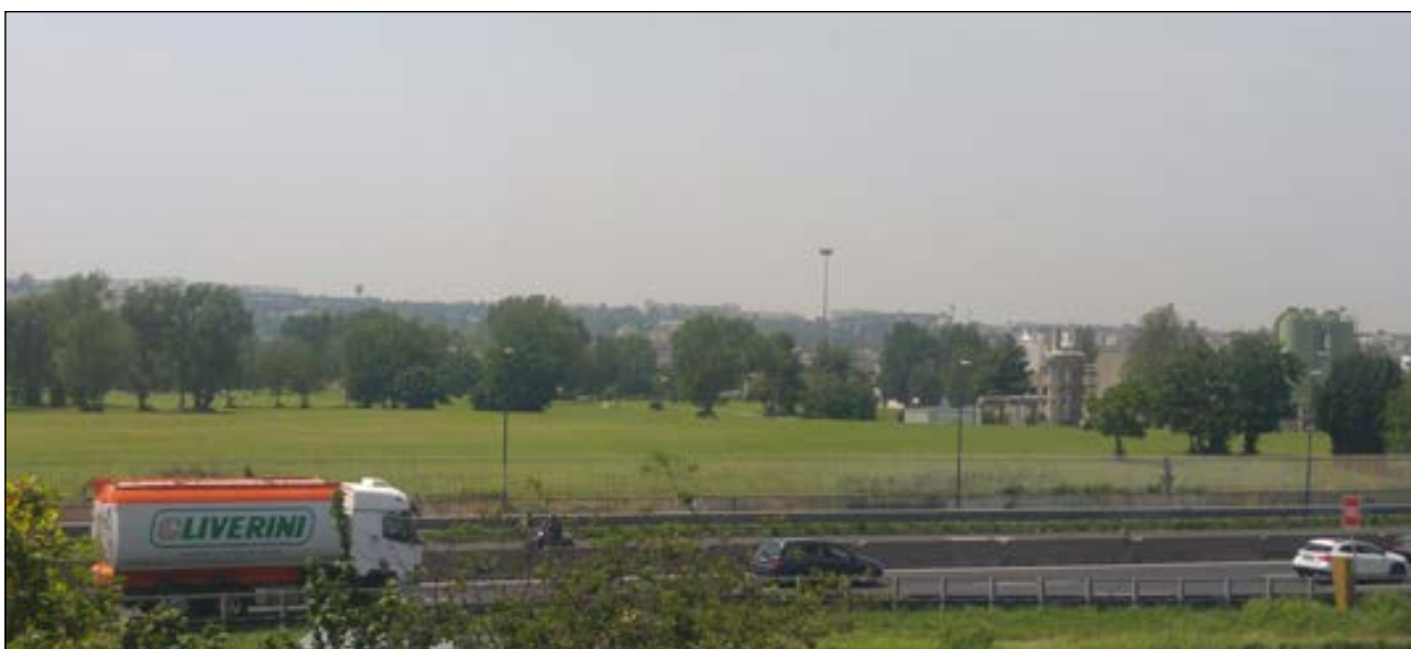
IMMAGINE 3 - Vista generale dell'area di intervento (Autostrada A1 _ Lato Sud-Ovest)
