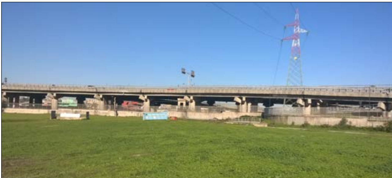
IMMAGINE 13 - Vista del contesto posto sul lato Nord: al centro il manufatto idraulico da cui inizia il tombamento
