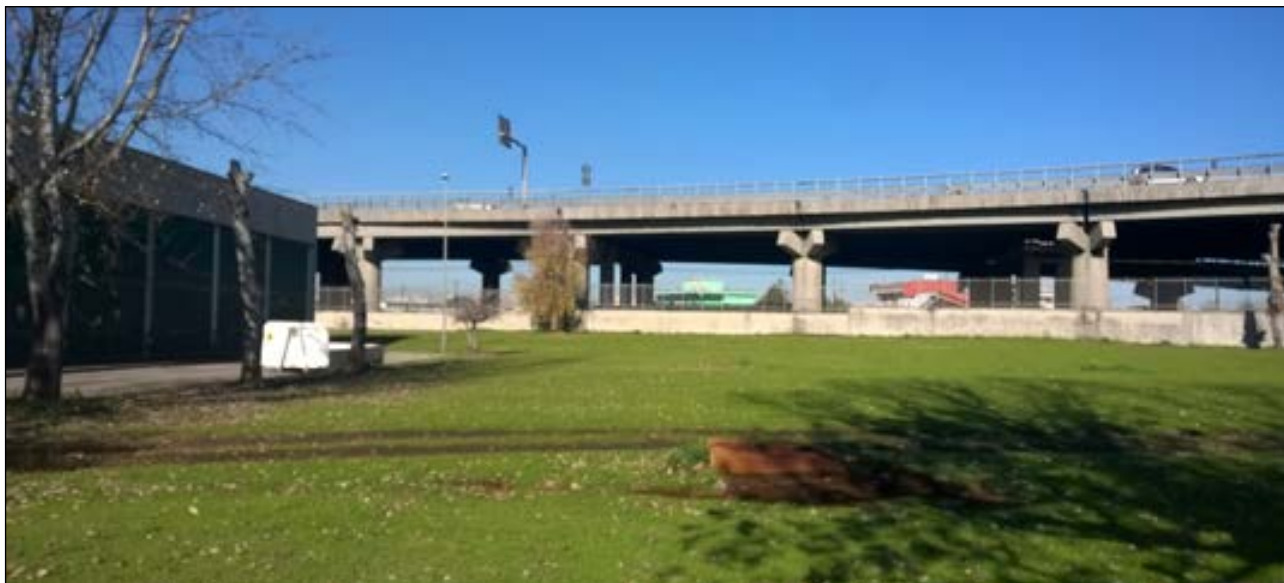
IMMAGINE 10 - Vista della sopraelevata della SS162dir e della sottostante Strada Comunale Galeone
