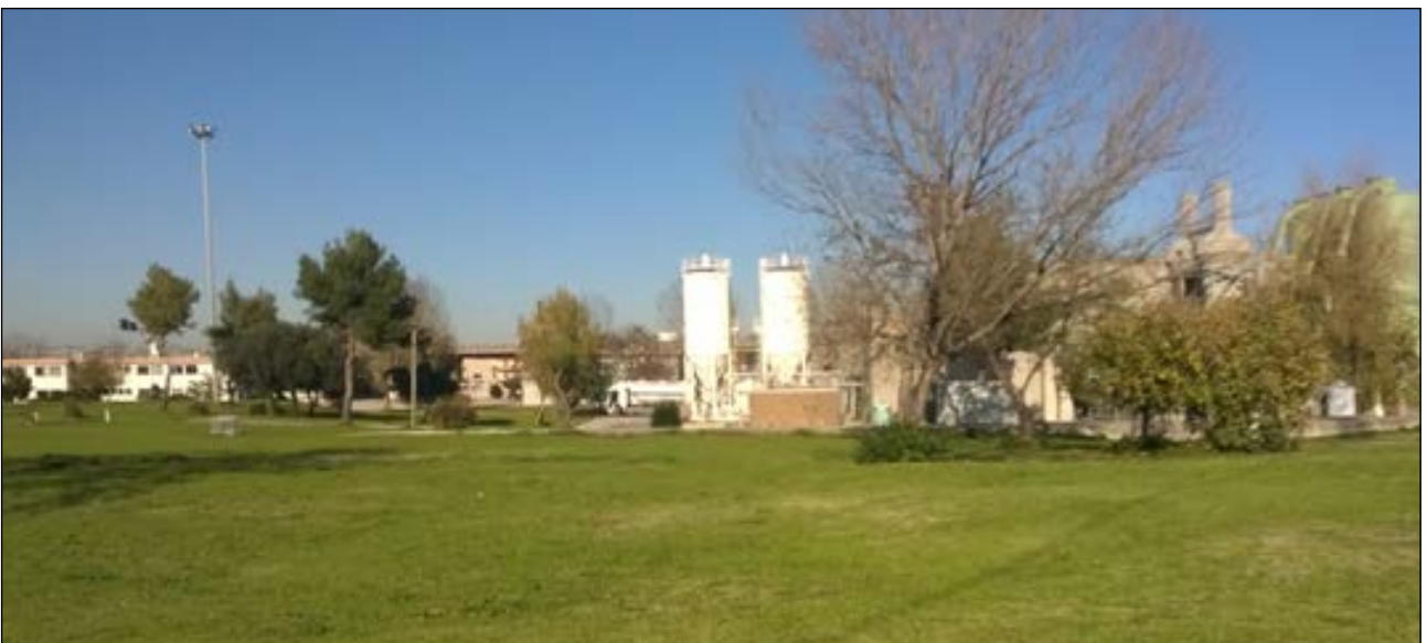
IMMAGINE 18 - Vista ripresa dal centro del lotto verso il lato Nord; dettaglio di elementi impiantistici del Depuratore
