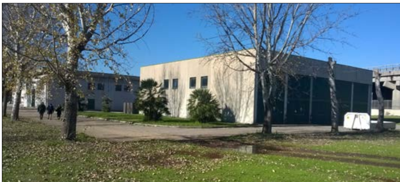
IMMAGINE 11 - Vista di dettaglio dei capannoni del Depuratore di Napoli Est posti sul lato Nord-Ovest del lotto
