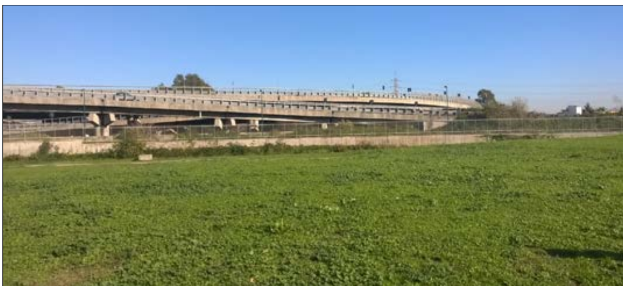
IMMAGINE 12 - Vista di dettaglio delle infrastrutture autostradali sul lato Nord-Est e dei pozzetti del Fosso tombato
