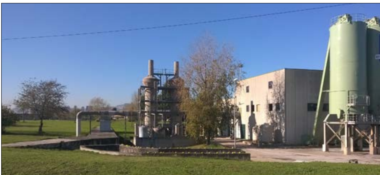
IMMAGINE 15 - Vista di dettaglio di elementi impiantistici del Depuratore di Napoli Est posti sul lato Ovest del lotto
