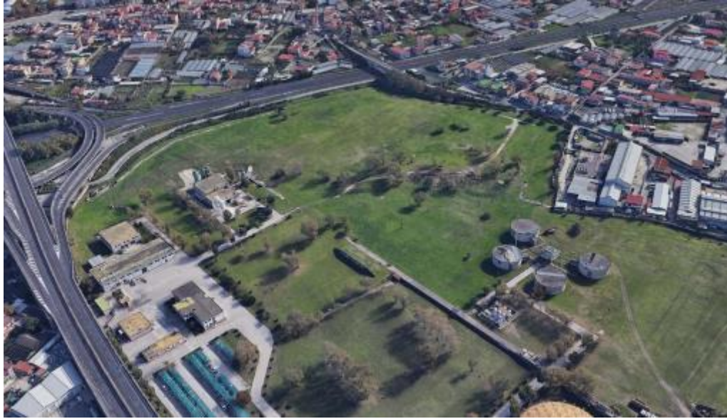
Fig.8.Vista aerea impianto di compostaggio. Stato di fatto.
