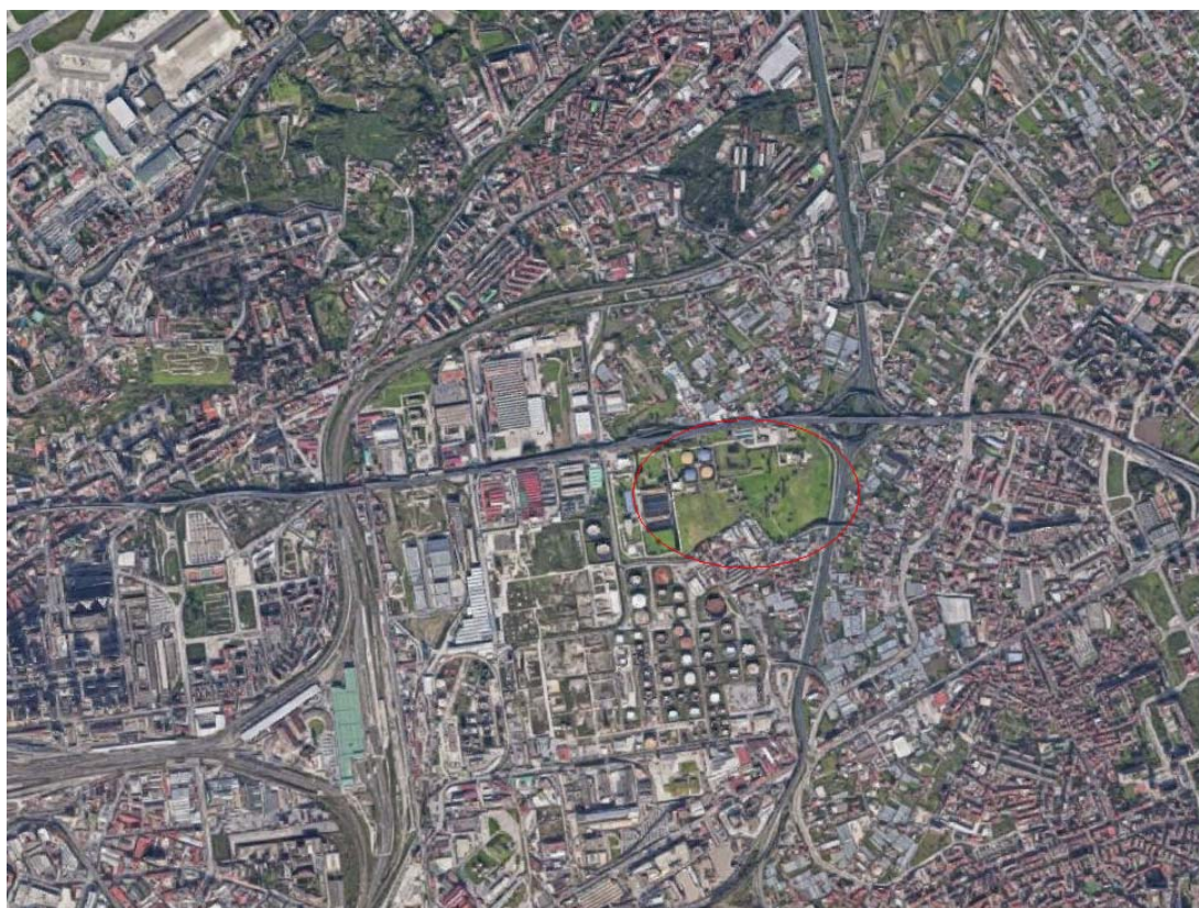
Fig. 3 - ubicazione area intervento Google earth.
