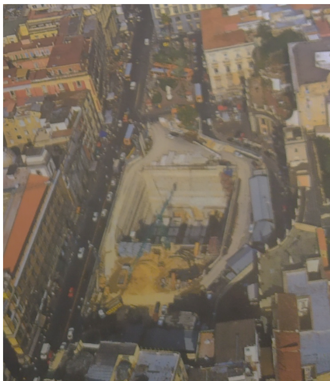
Piazza Dante con lo scavo a cielo aperto della metropolitana linea 1
