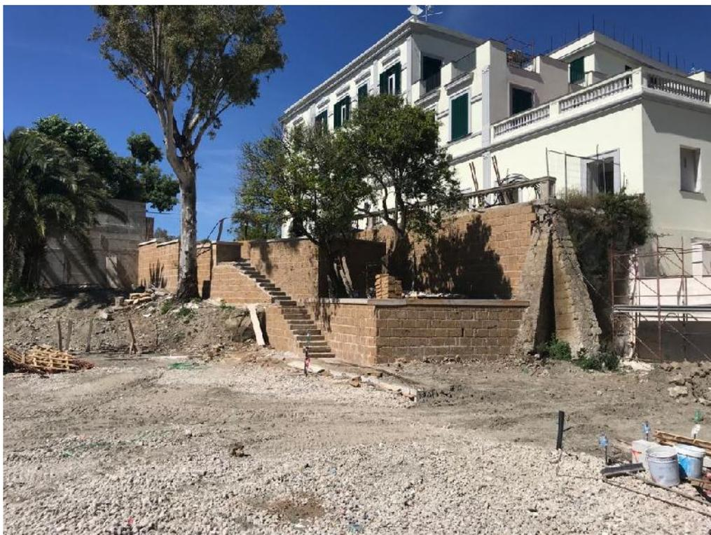
*Foto n° 1 - Sistemazione delle opere di contenimento ad ovest tra le residenze ed i campi sportivi, con rimodulazione e messa a norma della scala di collegamento esistente*
