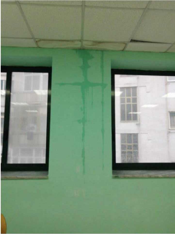
perdita da tetto con gocciolamento e danneggiamento alla parete
