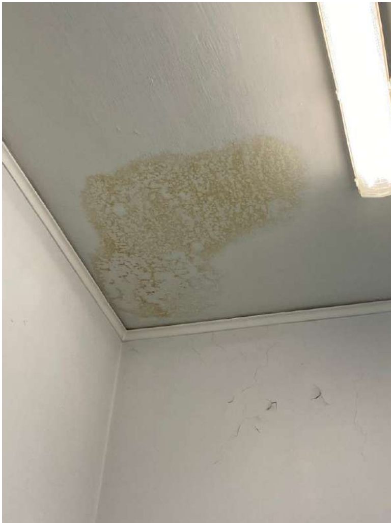
Foto 16. Infiltrazione nell'aula sottostante i locali sottotetto
