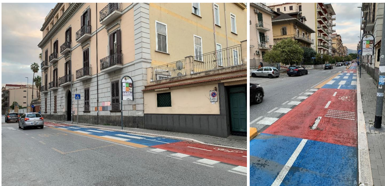
Segnaletica in prossimità di passo carrabile e interferenza pedone-ciclisti in area sosta autobus (città di Caserta)
