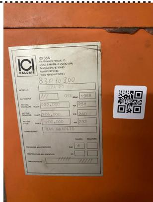
**Foto 35 – Targa caldaia**
