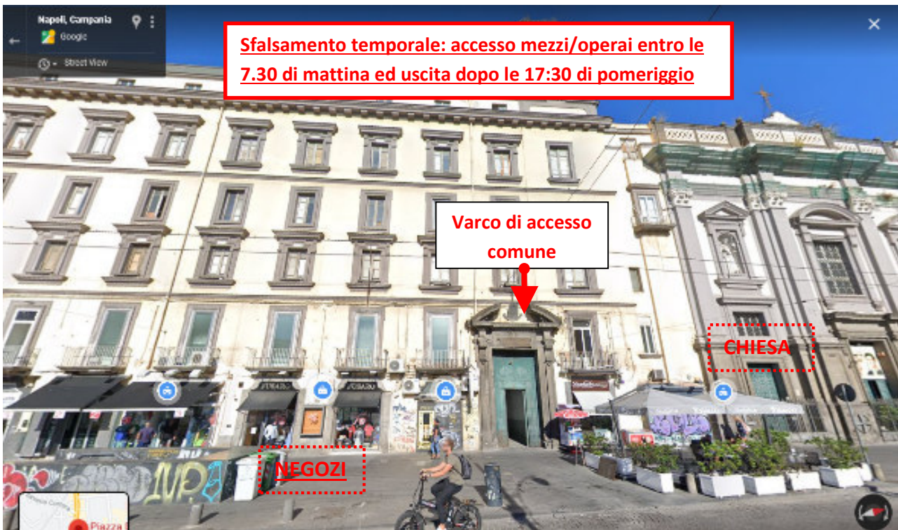
Immagine 3 – Interferenza varco accesso autogru/mezzi e varco di accesso al pubblico e personale Ente.
