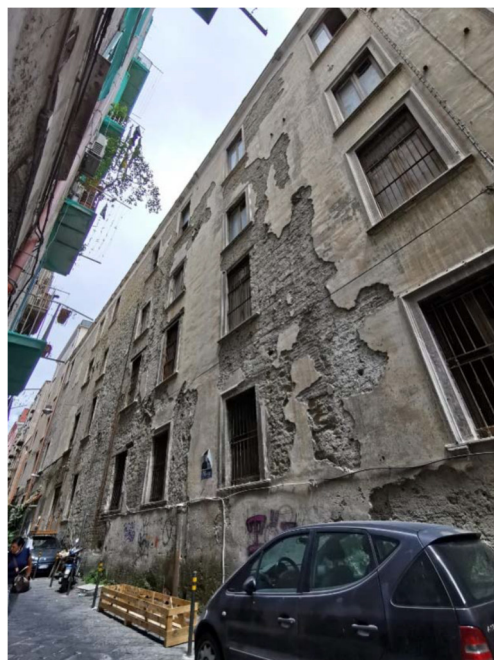
Prospetto su vico San Domenico Soriano
