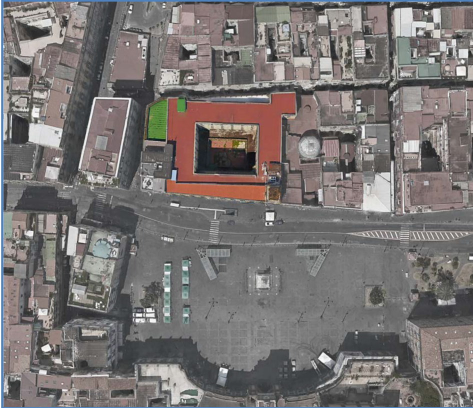
Immagine1 – vista aerea (rif. google.maps)
