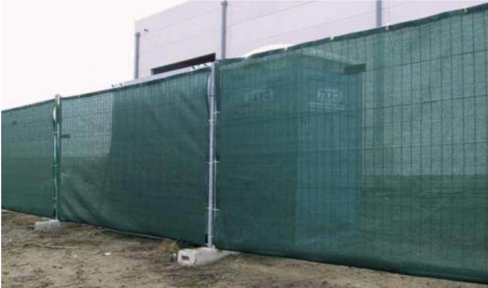
**Figura 2** – Esempio di recinzione con teli antipolvere
