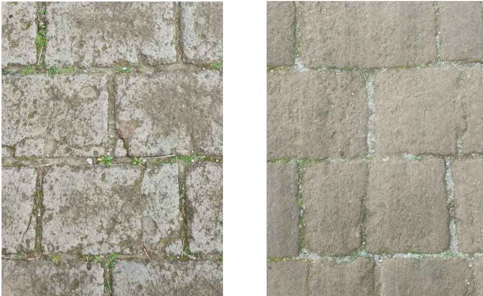
Le diverse qualità di tufo delle pavimentazioni esistenti
