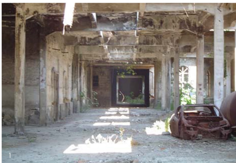
Fig. 4 – Particolare del corpo di fabbrica realizzato con struttura in cemento armato e risalente probabilmente alla fine degli anni venti del Novecento nel complesso ex Dent Allcroft & Co poi Pellami f.lli De Simone. Il punto di vista della foto è indicato in pianta dal cono ottico n. 1.
