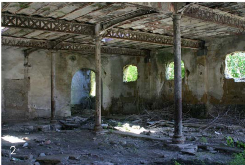
Fig. 3 – Particolare del corpo di fabbrica con colonnine in ghisa sormontate da archi ribassati e travi a traliccio, che sorreggono solai in ferro e voltine in laterizi nel complesso ex Dent Allcroft & Co poi Pellami f.lli De Simone. Il punto di vista della foto è indicato in pianta dal cono ottico n. 2.
