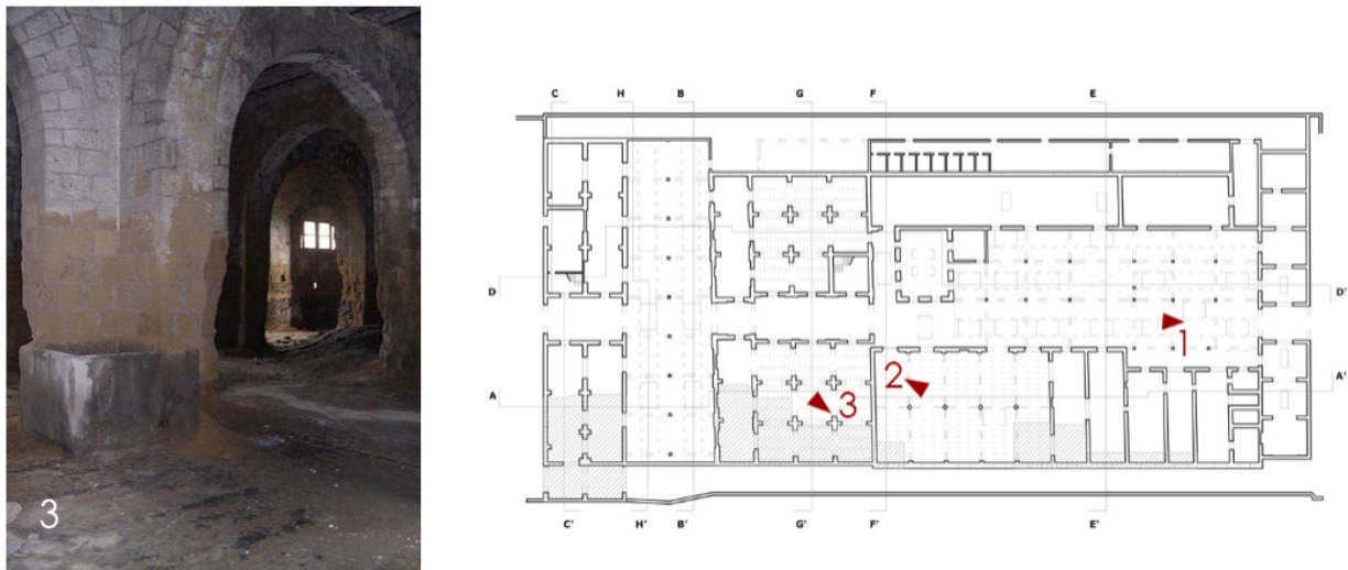
Fig. 2 – Particolare del corpo di fabbrica più antico, in muratura di tufo e struttura ad archi e pilastri, del complesso ex Dent Allcroft & Co poi Pellami f.lli De Simone. Il punto di vista della foto è indicato in pianta dal cono ottico n. 3.
