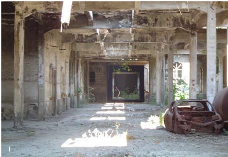
Figura 3 - Complesso ex Dent Allcroft & Co, poi Pellami f.lli De Simone. Il corpo di fabbrica in calcestruzzo armato.
