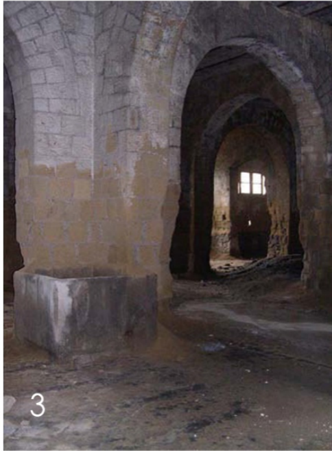
Figura 1 - Complesso ex Dent Allcroft & Co, poi Pellami f.lli De Simone. Particolare del corpo di fabbrica in muratura datato al 1828 e realizzato forse su preesistenze.
