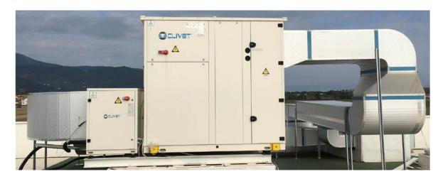
Quando la temperatura dell'aria esterna lo permette, queste unità funzionano in **modalità free- cooling,** immettendo aria esterna fresca e purificata senza attivare i compressori.
