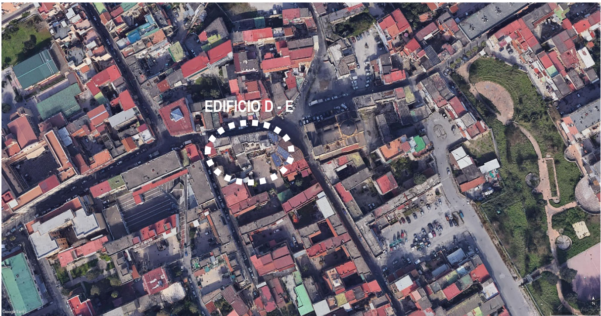
Vista aerea impianto – Edifici D ed E
