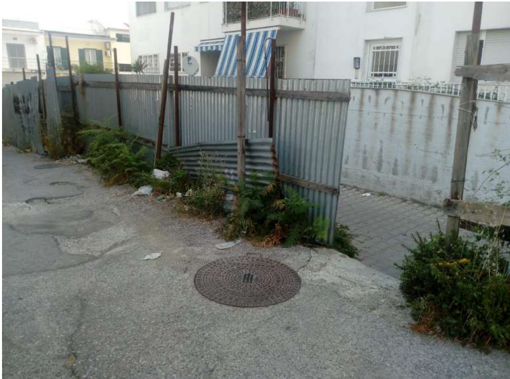
Area accesso edificio B
