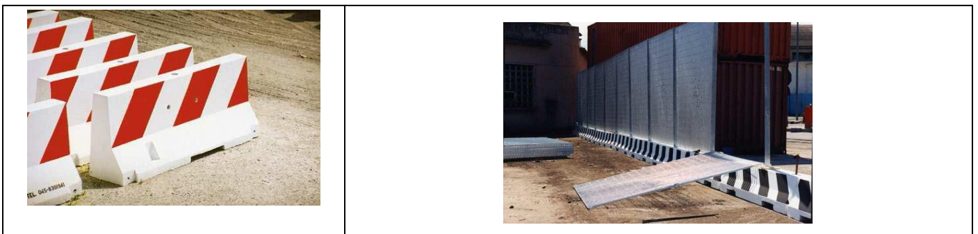
fig. 4.2 – Barriere di cls con soprastanti rete di recinzione e lampade di sicurezza rosse
