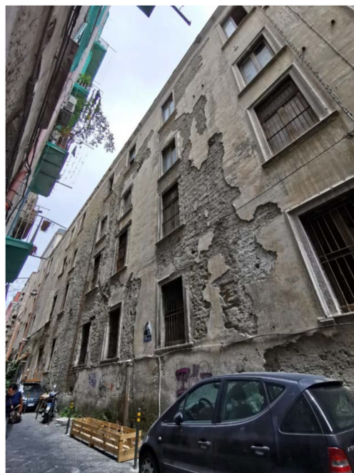
Prospetto su vico San Domenico Soriano
