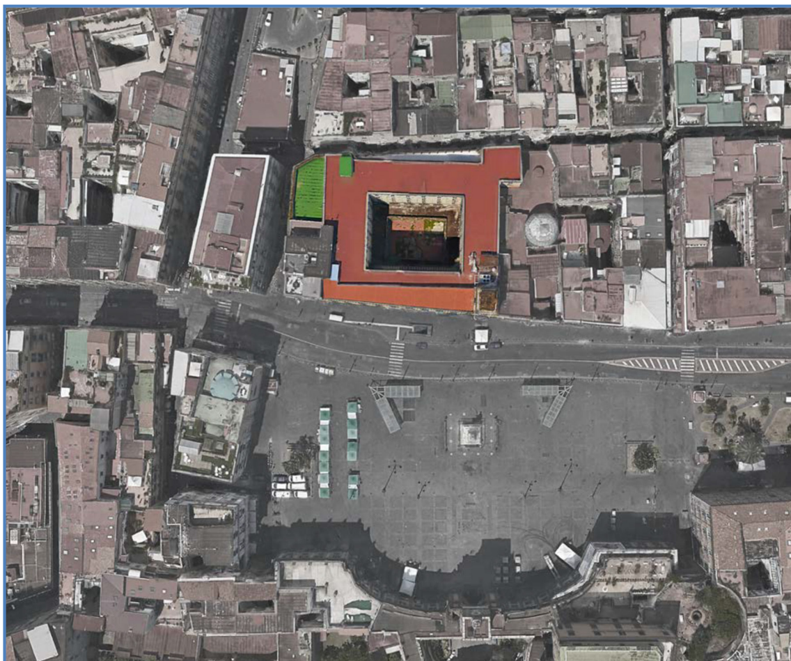
Immagine 2 – vista aerea con indicazione edificio oggetto di intervento (rif. google.maps)
